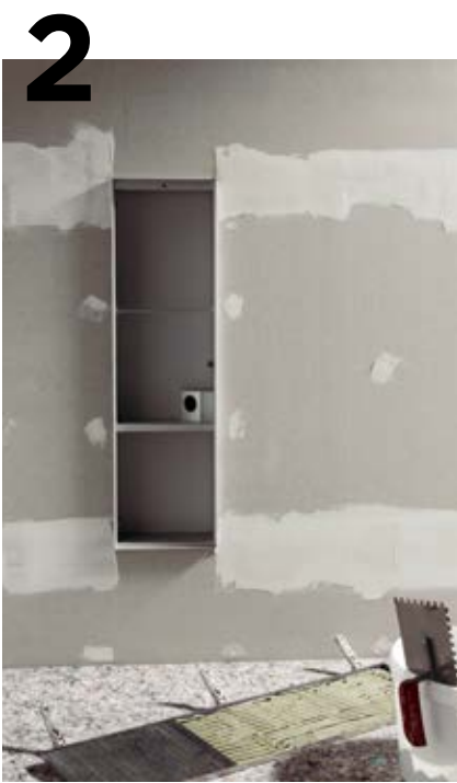
Die Tür wird temporär ausgebaut, damit sie einfacher verflieset werden kann.
