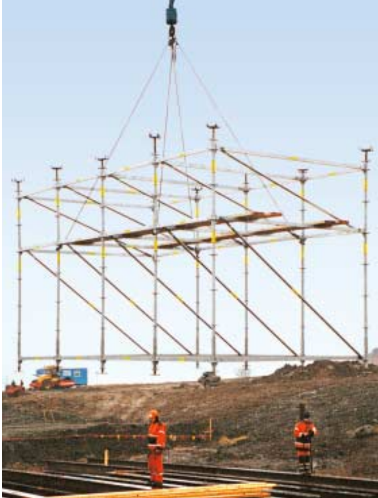
Sollevamento di un'unità premontata, mediante gru.
