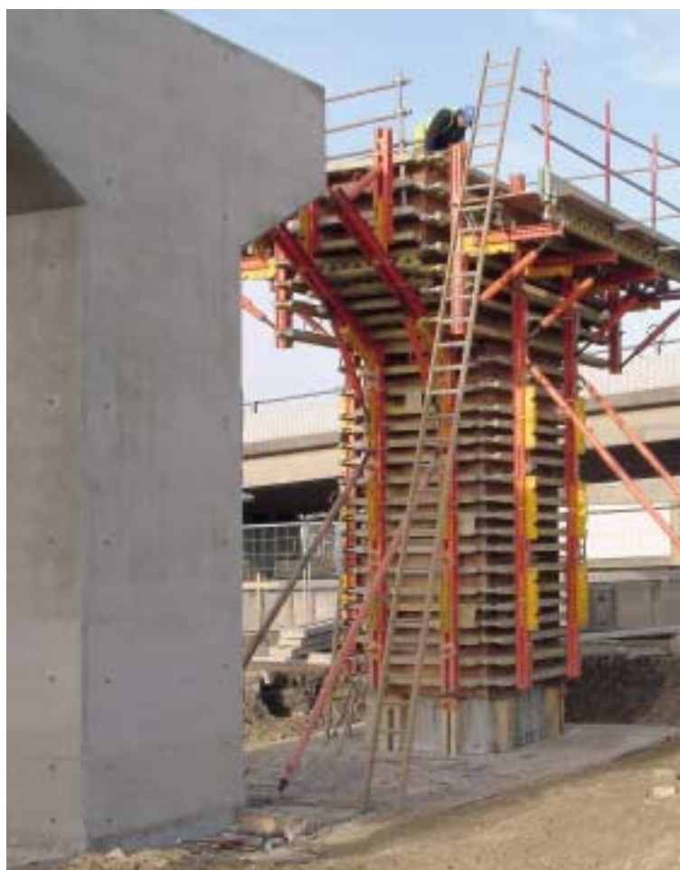
Pile monolitiche con e senza cassaforma.
