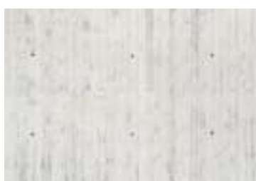
Il risultato è una finitura superficiale del cls, in questo caso con impronta in legno.
