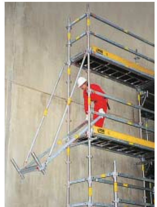
Montaggio di uno sbalzo con una diagonale tra nodi.
