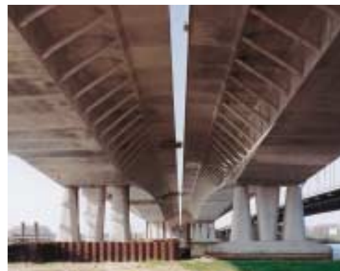
Vista da sotto del ponte, con i due impalcati in parallelo, dove verranno realizzate le corsie stradali.
