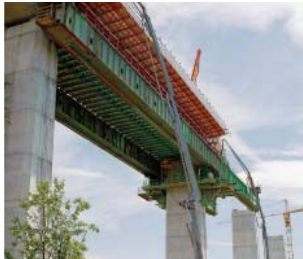
Centina autovarante con cassaforma in posizione di getto.
