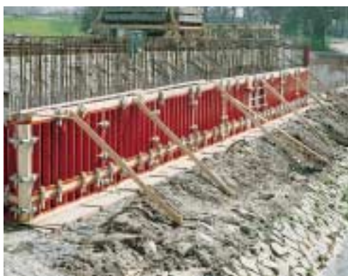
Costruzione del ponte di Acher. Fondazioni: cassaforma PERI con rivestimento in tavole di legno Impresa: Consorzio Bilfinger & Berger, Max Früh
