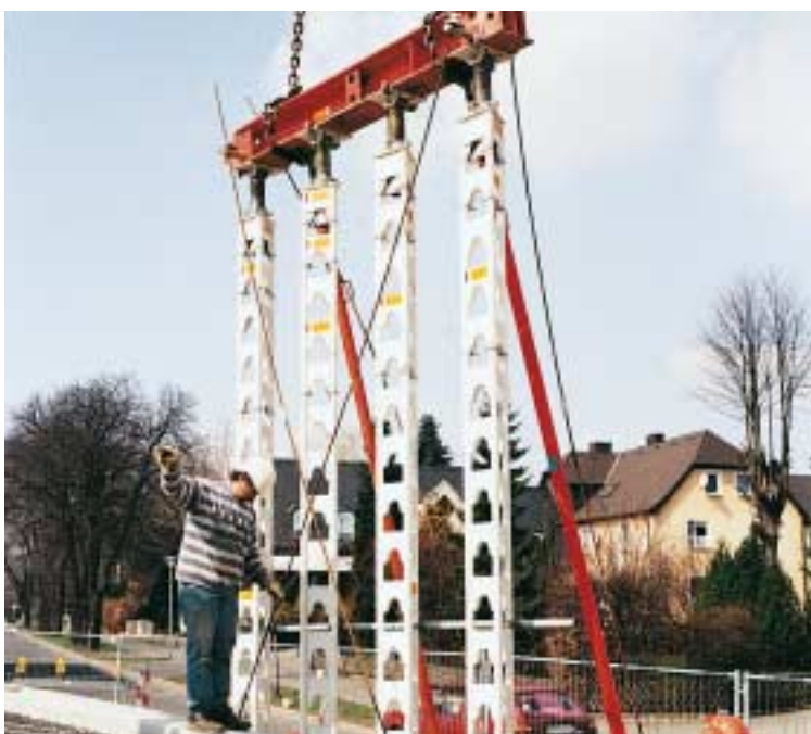
Sollevamento con gru di stilate di puntellazione preassiate.
