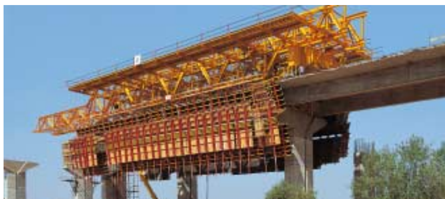
Anche dopo il getto della sovrastruttura del ponte è possibile spostare le unità di cassaforma grazie alle guide di scorrimento.
