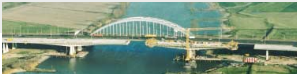
Cassaforma per conci gettati a sbalzi simmetrici, per la campata principale del ponte Lek, in Olanda. Partendo dalle pile vicine alle sponde del fiume, la campata viene realizzata con conci a sezione scatolare precompressi su ciascun lato per circa 80 m, fino a raggiungere il centro della campata.
