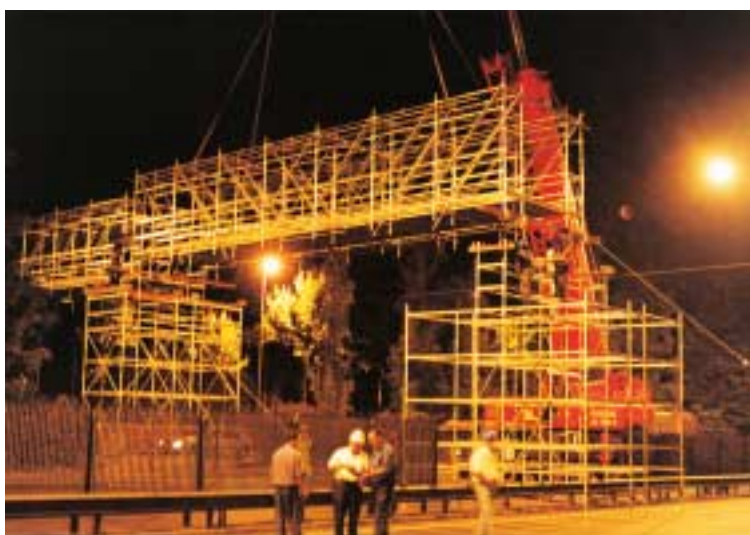
Le campate del ponte vengono sollevate dall'autogru per i punti di attacco preposti e posizionate.
