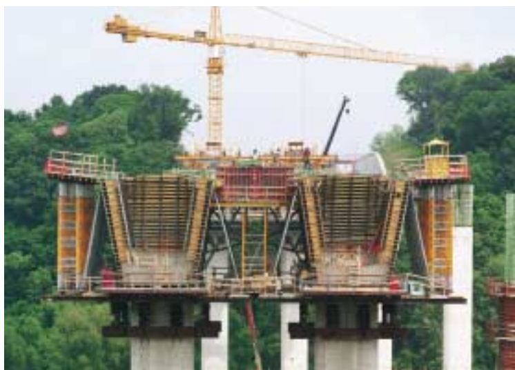
Per i conci delle teste pile delle pile accoppiate n. 9 sono stati utilizzati tra 620 e 860 m 2 di cassaforma.
