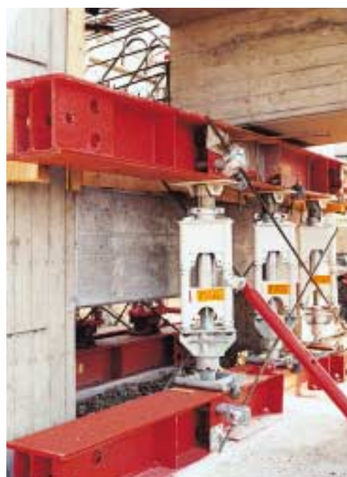
Altezza minima dei puntoni costituiti da: albero con testa, segmento di 30 cm e meccanismo di base.
