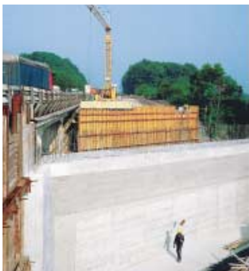
Sottopasso autostradale nei pressi di Kirchheim/Teck. Cassaforma a travi VARIO di notevole altezza. Impresa: Leonhard Weiss, Germania
