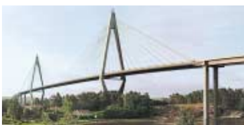
I due piloni N1 (120 m) ed S1 (141 m) sostengono l'impalcato che ha una luce libera di oltre 414 m.
