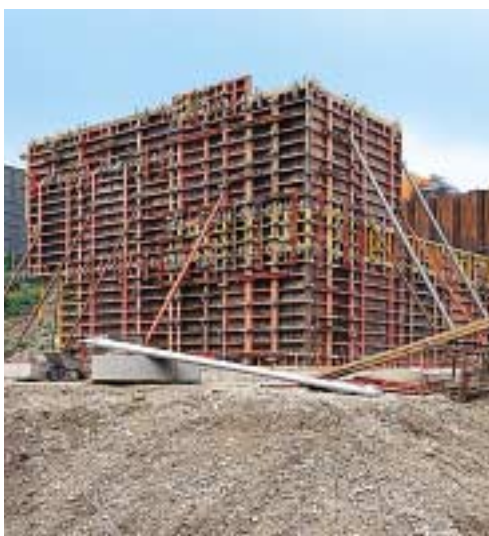
Spalla realizzata con cassaforma TRIO.
