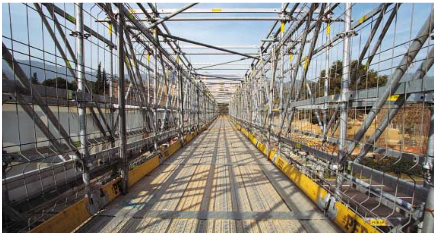
Il sovrappasso pedonale lungo 40,00 m realizzato semplicemente con componenti del ponteggio.
