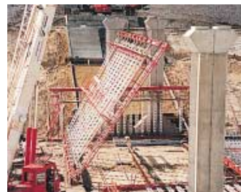
Una volta completato il preassemblaggio delle unità d'impalcature di sostegno, vengono erette le stilate di puntoni.
