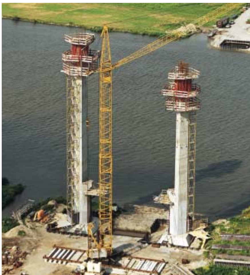
Cassaforma a ripresa PERI per pile con forma geometrica complessa. Ponte sospeso di Delfjssel, Kampen, Olanda.
