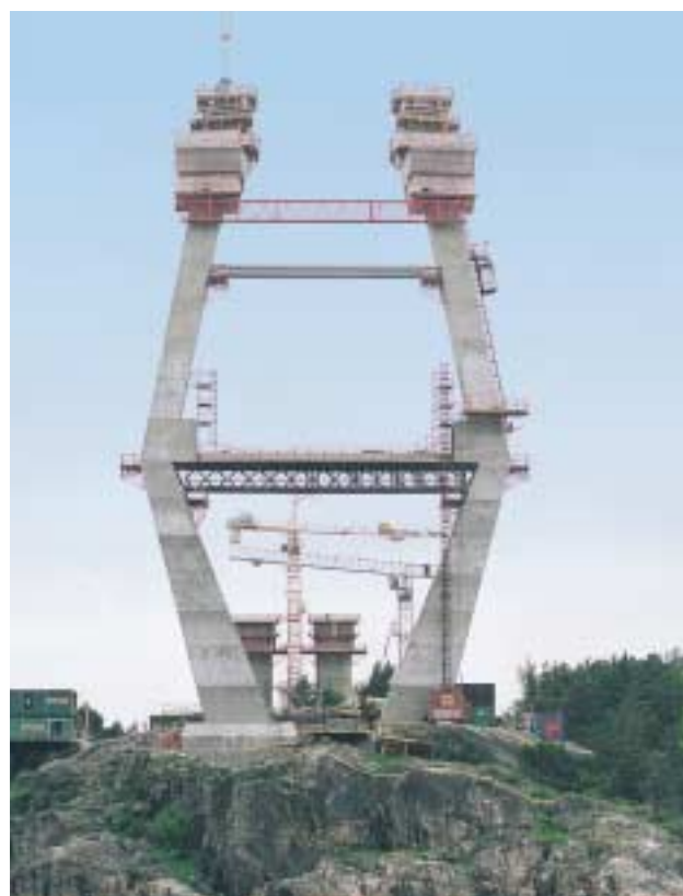
I due piloni N1 (120 m) ed S1 (141 m) sostengono l'impalcato che ha una luce libera di oltre 414 m.
