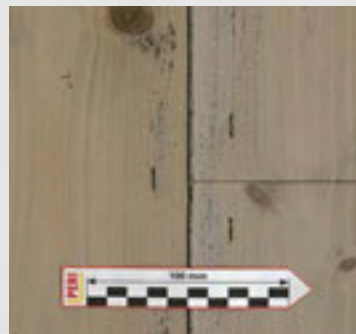
Esempio di fissaggio con graffette
