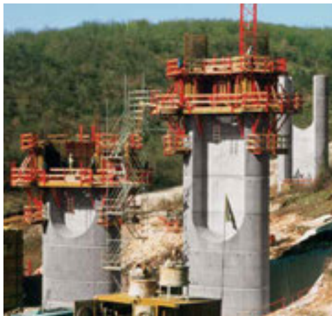
I due dotazioni di casseforme, che sono state reimpiegate per 50 volte, hanno permesso di realizzare le sei coppie di pile del viadotto nei tempi previsti.
