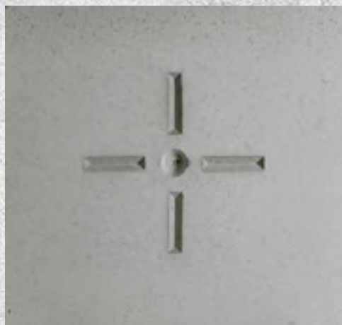
Impronta di un "ancoraggio cieco"
