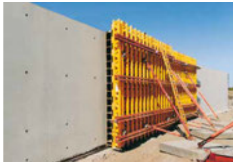
Eccellente finitura superficiale con VARIO GT 24 e giunzione VKS per calcestruzzo a vista.
