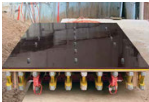
Modulo di cassaforma VARIO GT 24, pronto per la messa in opera, con coni ciechi e spruzzato con disar-mante.
