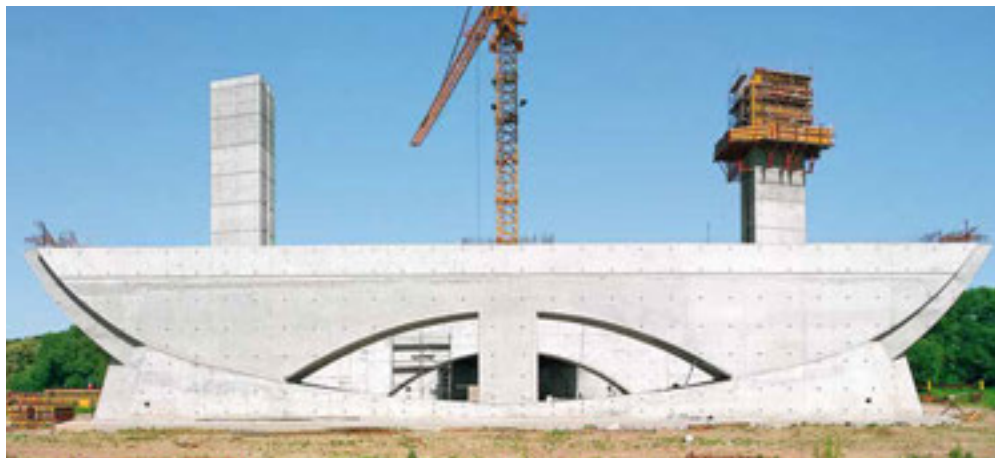
...che ha consentito di ottenere una perfetta finitura superficiale del calcestruzzo.
