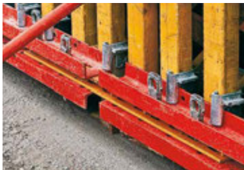
Grazie all'impiego della giunzione VARIO per calcestruzzo a vista, si possono ottenere giunti tra moduli di cassa-forma senza dislivelli.
