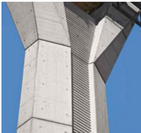
Viadotto Schleuse, Schleusingen, Germania
