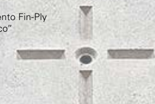
Impronta di un "ancoraggio cieco"
