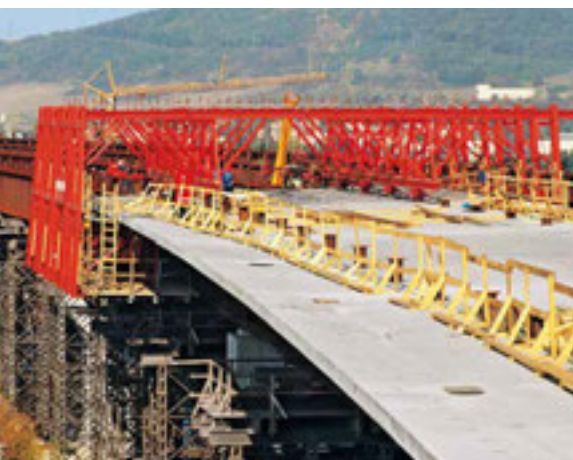
Sistemi PERI per la realizzazione di 59 pile in calcestruzzo a vista e incastellatura traslabile PERI per impalcati a struttura mista.
