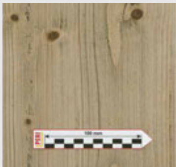
Dettaglio dell'impronta sulla superficie del calcestruzzo
