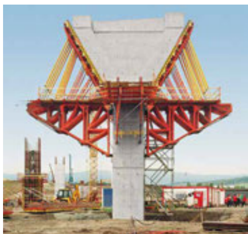
Per la realizzazione dei pulvini gli ingegneri PERI hanno sviluppato un'efficiente soluzione con cassaforma a travi per pareti VARIO GT 24, sostenuta da contrafforti SB montati in posizione orizzontale.
