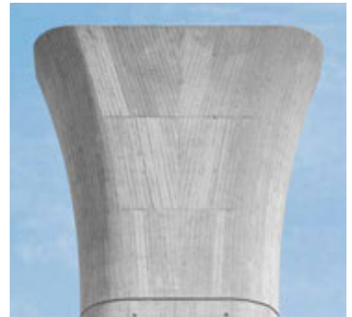
Perfezione di forma e finitura: uno dei 16 pulvini a fine lavori.
