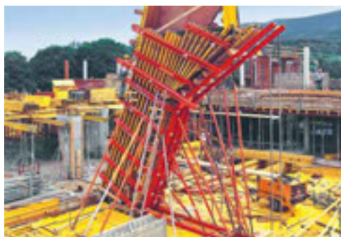
Posizionamento della cassaforma per i pilastri inclinati, progettata ad hoc da PERI.
