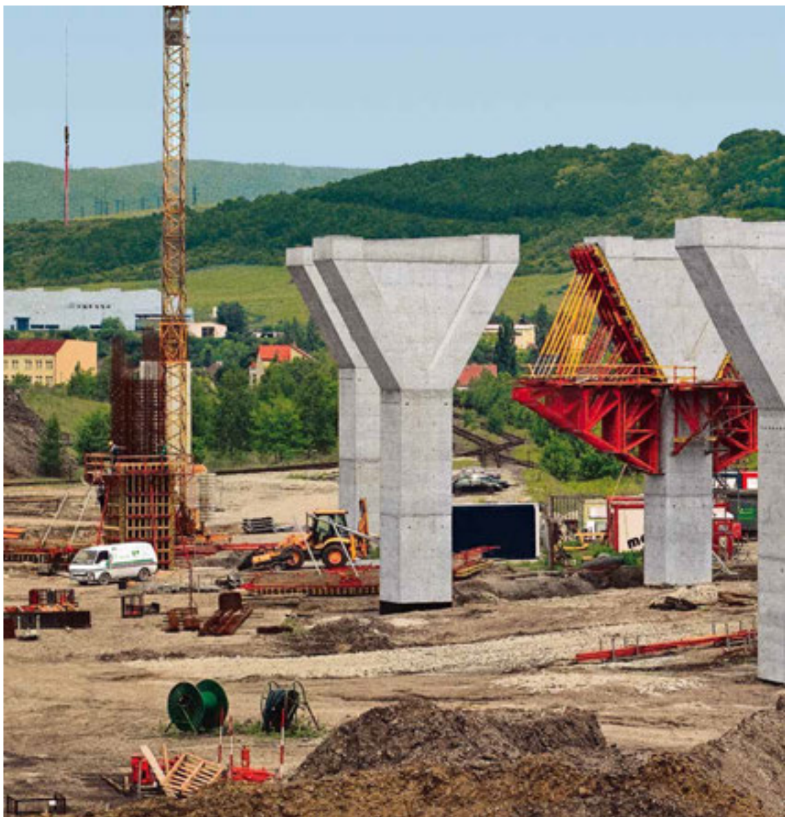
Sistemi PERI per la realizzazione di 59 pile in calcestruzzo a vista e incastellatura traslabile PERI per impalcati a struttura mista.
