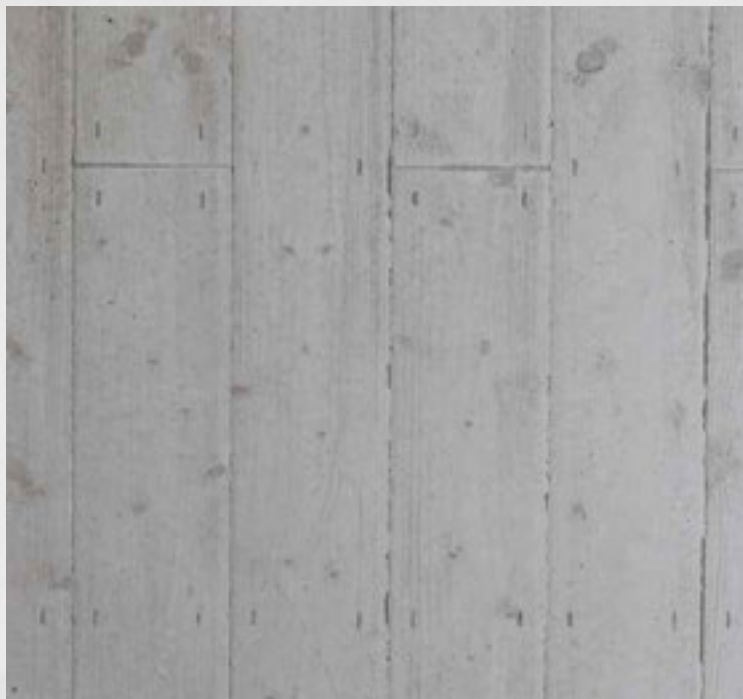
Esempio di fissaggio con graffette
