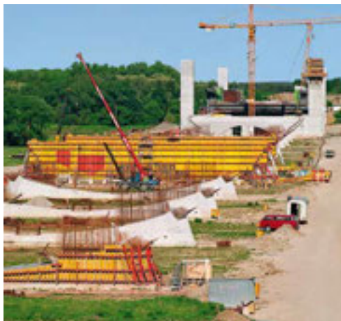
Le pile fuori alveo sono state realizzate con il sistema di cassaforma a travi per pareti VARIO...
