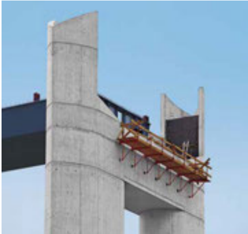
L'impressionante pila alta 126 m è realizzata in cemento armato fino al livello dell'impalcato, la parte restante è in acciaio.
