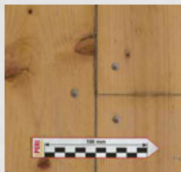
Esempio di fissaggio con chiodi
