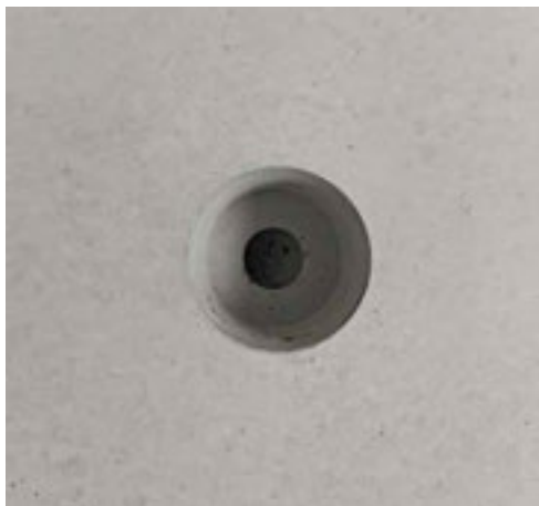
Foro lasciato da un cono in plastica, senza tappo conico
