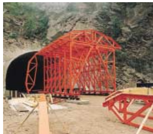
Montaggio delle centine laterali ripiegabili.
