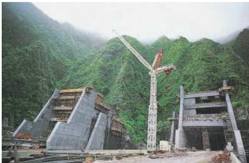
Vista del portale d'ingresso e uscita.
