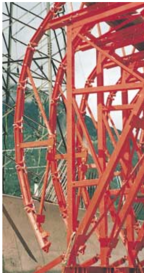
Montaggio della sezione ampliata in corrispondenza delle piazzole. In primo piano si evidenziano i componenti di serie: le puntellazioni di sostegno SB 2 e i correnti a snodo GRV.
