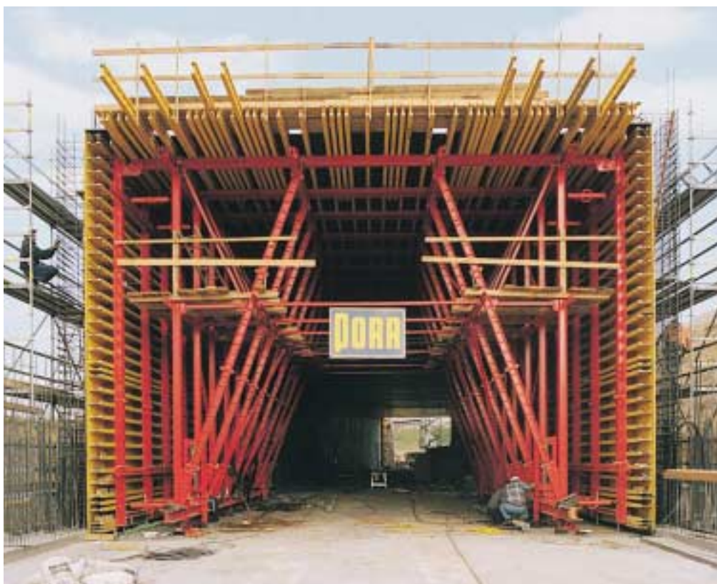
Cassaforma interna utilizzata per la sezione della galleria ferroviaria artificiale a due binari. Una volta terminata la posa in opera del ferro d'armatura, le casseforme per i piedritti vengono realizzate con i moduli VARIO.
