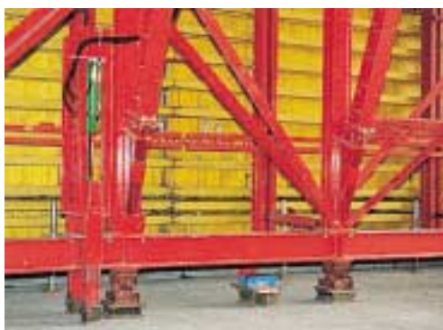
Meccanismo idraulico utilizzato per abbassare o alzare la cassaforma traslabile.
