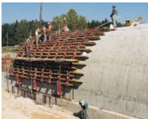
Vista della cassaforma esterna durante la fase di getto. In totale si sono realizzati otto conci ognuno della lunghezza di 10 metri.
