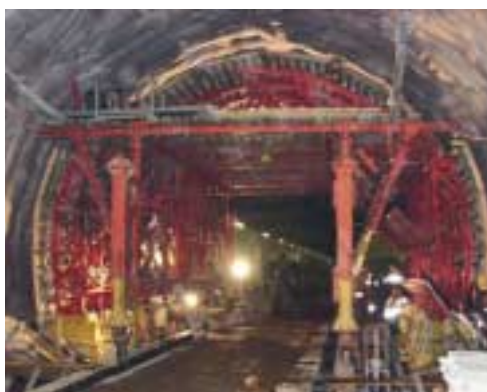
Carro semovente a portale La struttura della cassaforma traslabile consente il passaggio indisturbato dei veicoli del cantiere lungo la galleria. Galleria di Belchen, Svizzera.
