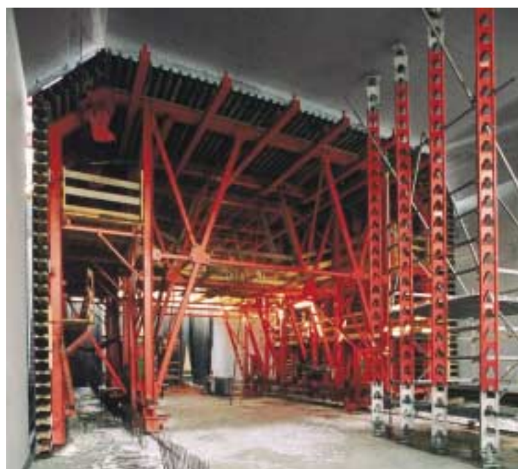
Cassaforma interna semovente in fase di traslazione (cassaforma traslata in corrispondenza del secondo ciclo di costruzione) poco prima di eseguire il getto di chiusura tra due conci. Nel cono di galleria già ultimato, i puntoni per stilate HD 200 vengono impiegati come puntellatura ausiliaria.
