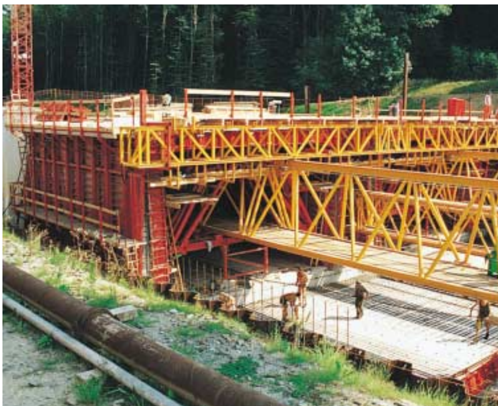
La cassaforma traslabile, con un peso complessivo di 210 t, era costituita da due casseforme interne per i conci delle gallerie, una cassaforma per il corridoio di servizio con le relative centine di traslazione, una cassaforma esterna e il fermagetto frontale.
