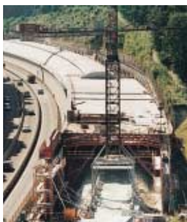
Nella sezione rettangolare le pareti di altezza fino a 8,00 m vengono realizzate con PERI TRIO. Solo in un secondo tempo si lavora con la cassaforma traslabile della soletta di copertura in conci di lunghezza 12,50 m.
