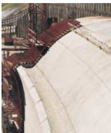
Il piedritto intermedio e l'inizio della calotta della galleria Est vengono realizzati contemporaneamente alla galleria Ovest.
