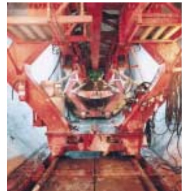
Il carrello di traslazione viene fatto arretrare per sollevare la cassaforma dell'arco rovescio (disarmo).
