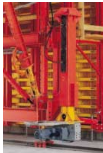
Dispositivo per il sollevamento e la movimentazione dotato di meccanismo idraulico e centralina elettrica.
