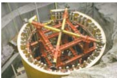
Cassaforma per condotta full-round (verticale), Svizzera.
