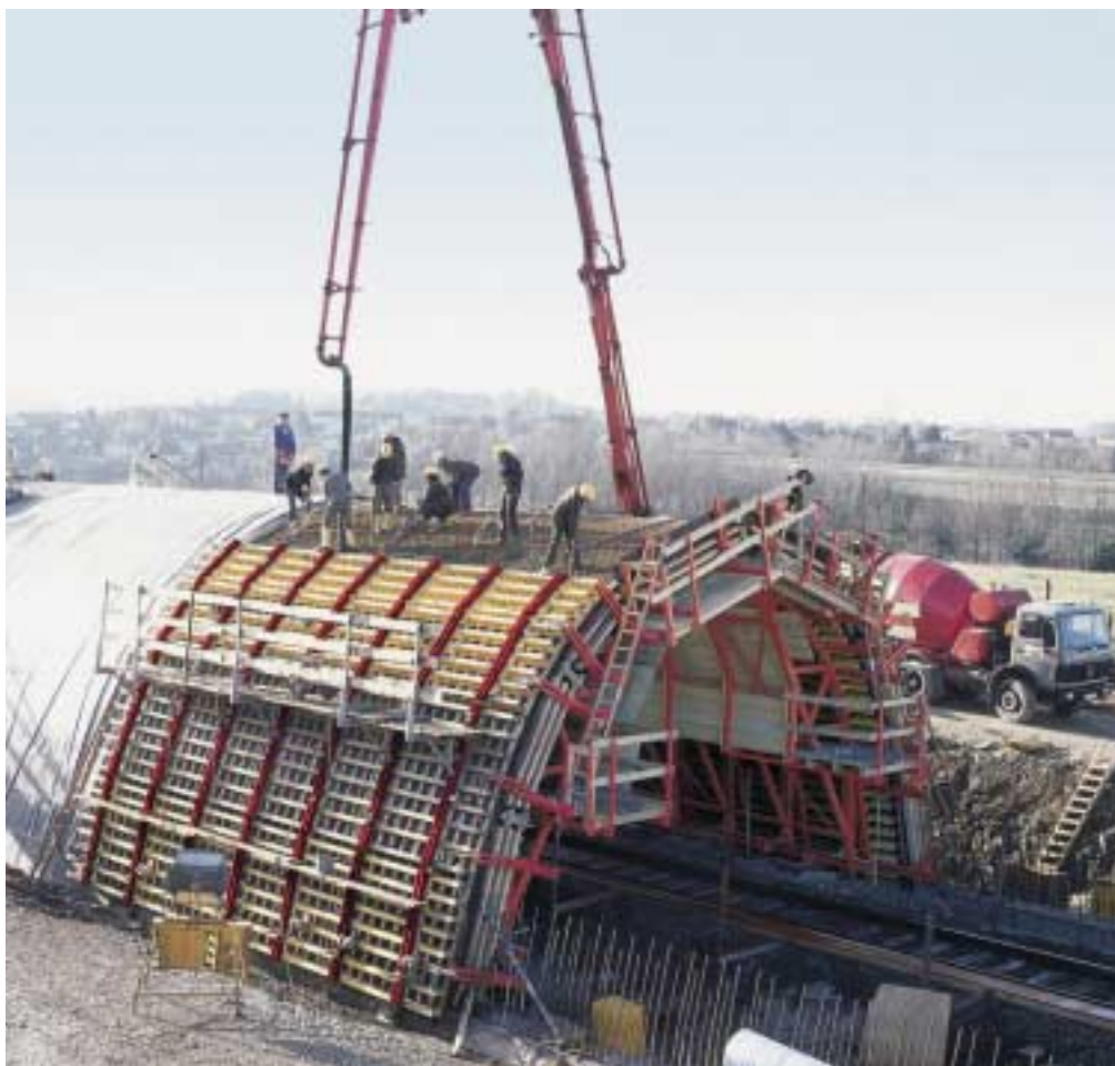
La realizzazione della sezione tipo è avvenuta con un ciclo di costruzione di una settimana per conci lunghi 10 m. Tutte le operazioni di movimentazione richiedevano soltanto 3 ore.
