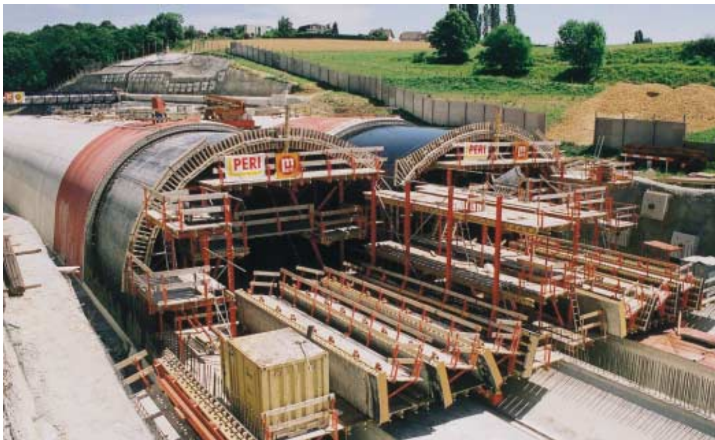
Una piattaforma di predisposizione che può essere movimentata con l'intera unità di cassaforma, sostiene le casseforme esterne dei piedritti durante la movimentazione per la successiva fase di getto.
