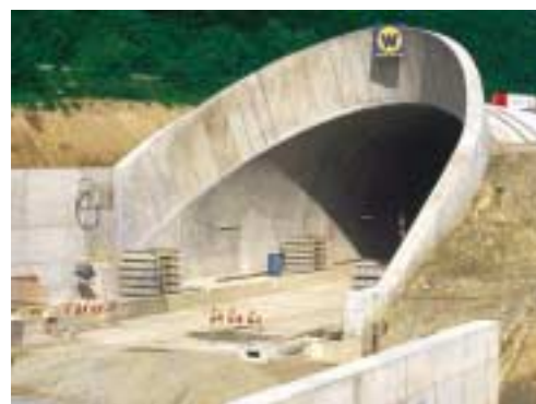
Portale a becco di flauto. Ingresso della galleria ferroviario ICE, Idstein, Germania.
