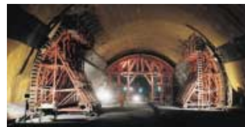
Tunnel di Crapteig, Svizzera: prima vengono realizzati i piedritti laterali, poi la calotta.
