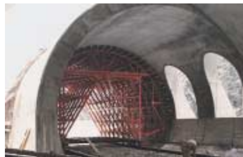
Galleria artificiale Valdisotto, Sondrio, Italia
