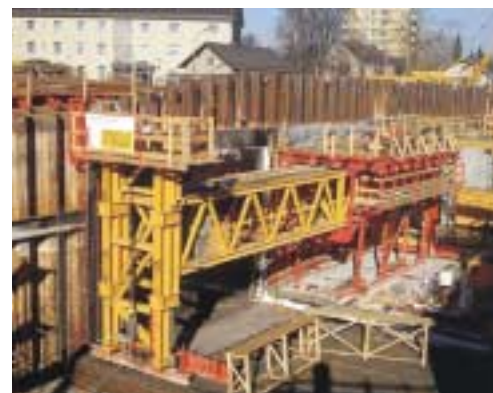
Montaggio: cassaforma interna posizionata su centina di traslazione spostata in avanti.
