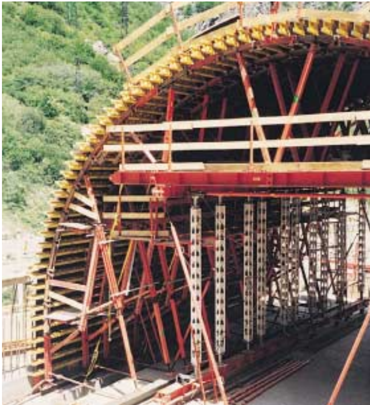
L'intera cassaforma interna è stata realizzata con componenti di serie ed è stata spostata completamente da un ciclo all'altro senza problemi.
