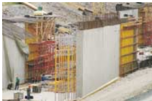
Galleria ferroviaria Diez realizzata per la nuova tratta Colonia-Francoforte (D).
