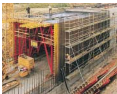
Cassaforma interna utilizzata per la sezione della galleria ferroviaria artificiale a due binari. Una volta terminata la posa in opera del ferro d'armatura, le casseforme per i piedritti vengono realizzate con i moduli VARIO.
