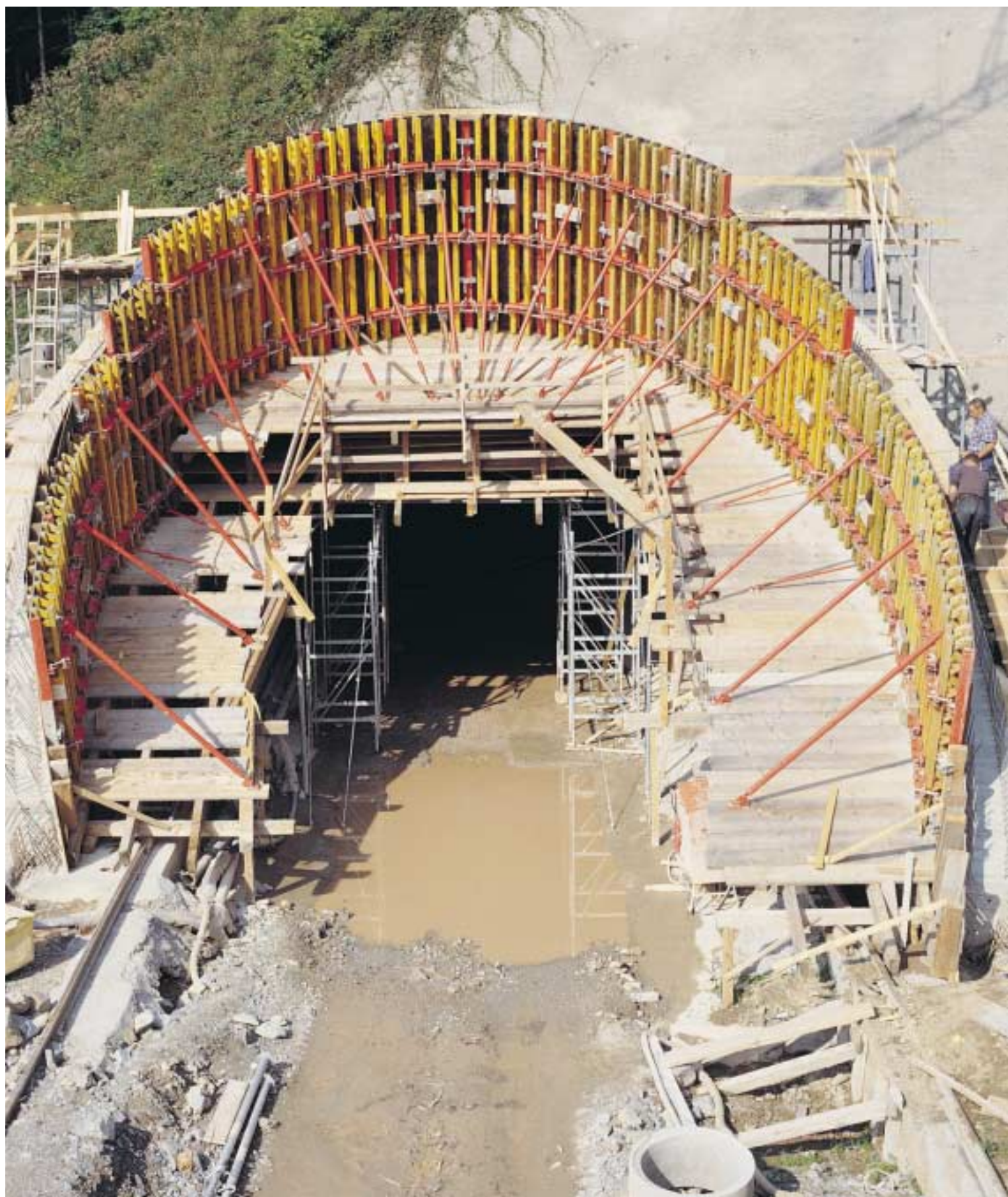
I gruppi di regolazione con filettatura esagonale hanno consentito di collocare i singoli moduli di cassaforma del portale sagomato a becco di flauto secondo il raggio necessario. La sottostruttura d'appoggio della cassaforma, realizzata con impalcature a torre di telai sovrapposti ST 100, sopportano i carichi garantendo la massima sicurezza.
