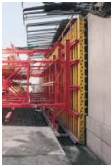
Finitura superficiale delle pareti della galleria della Schleifenstraße di Augusta (Germania).
