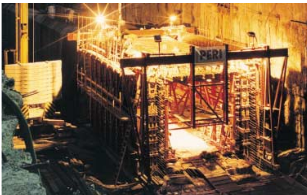
Veduta notturna del cantiere della metropolitana di Praga. La cassaforma proposta da PERI ha consentito di completare ogni ciclo di costruzione del tunnel in cinque giorni invece che in sette come previsto inizialmente.
