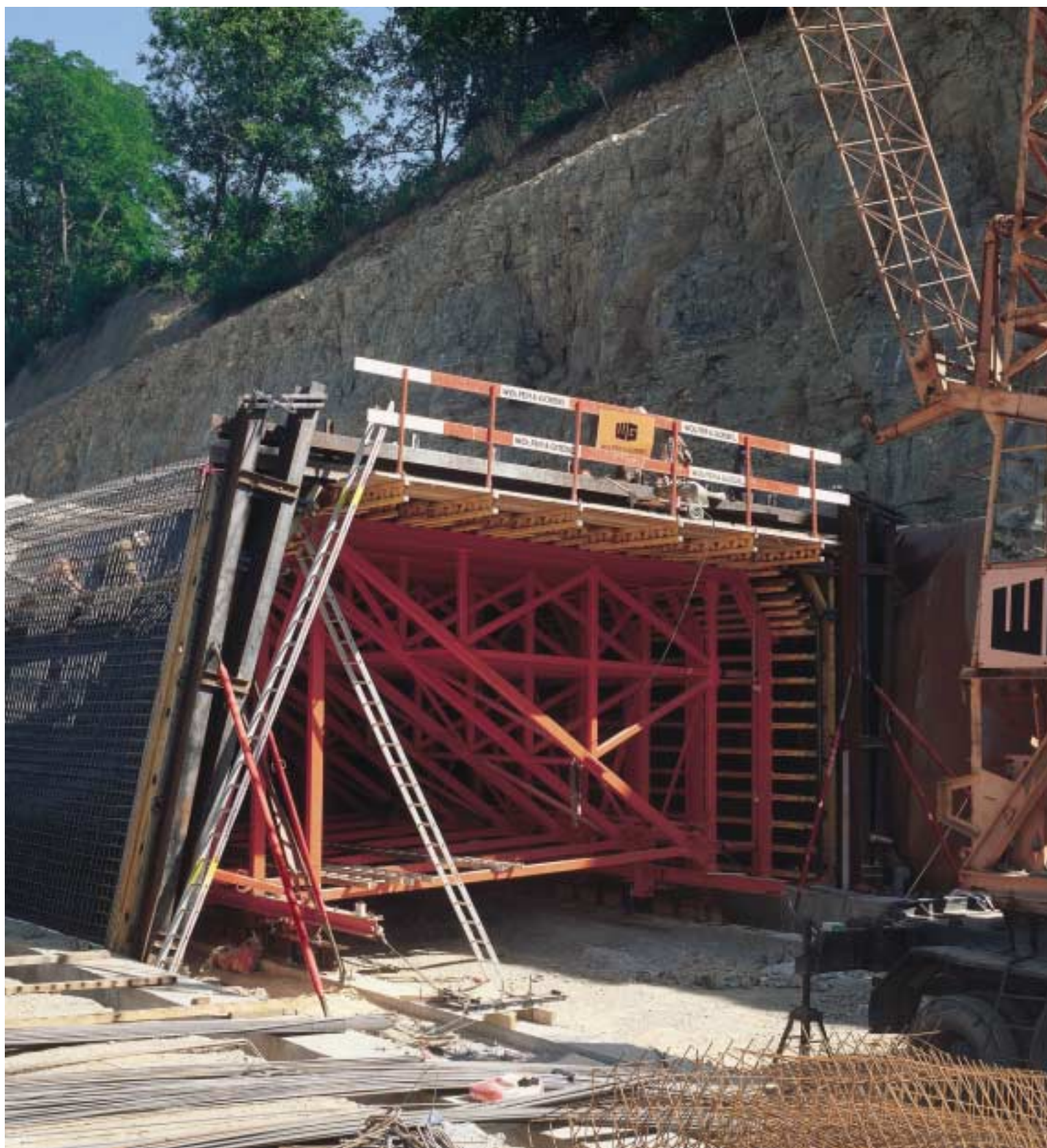
Cassaforma per galleria artificiale realizzata con componenti di serie PERI.
