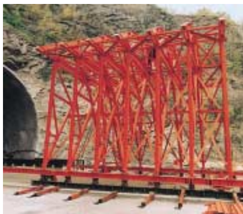
Le puntellazioni di sostegno SB 2 assiate per formare una struttura portante.
