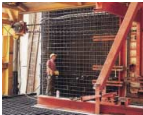
Movimentazione dell'attrezzatura provvisoria specifica PERI di una sezione armata con paranco motorizzato a catena.
