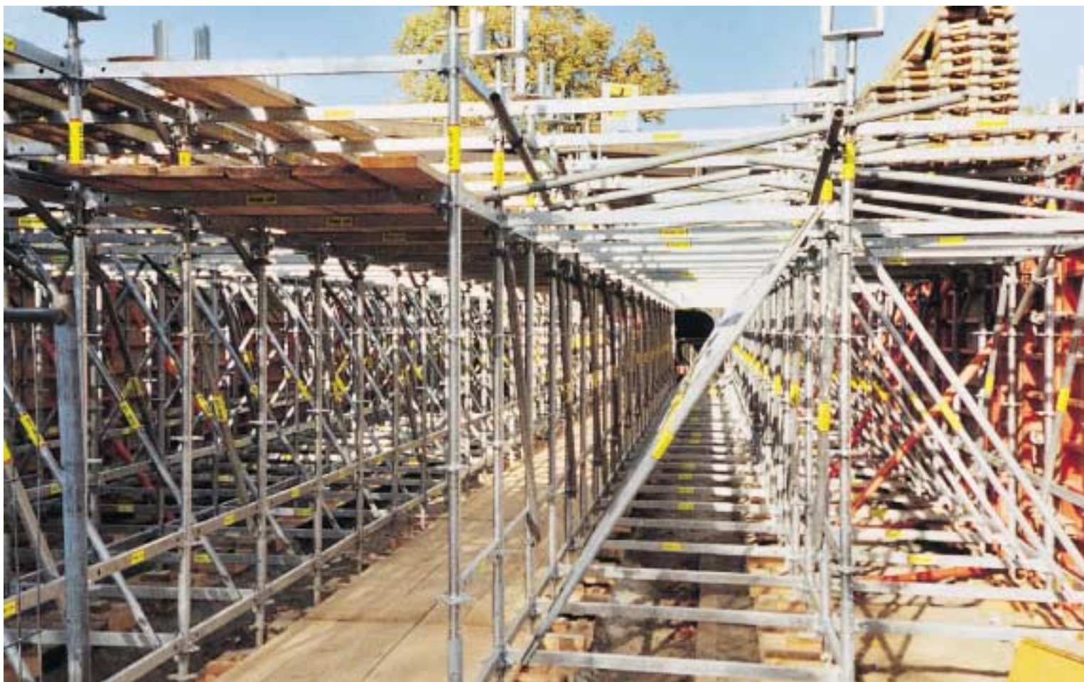
La campata centrale dell'impalcatura di supporto è stata utilizzata come passaggio per gli addetti.
