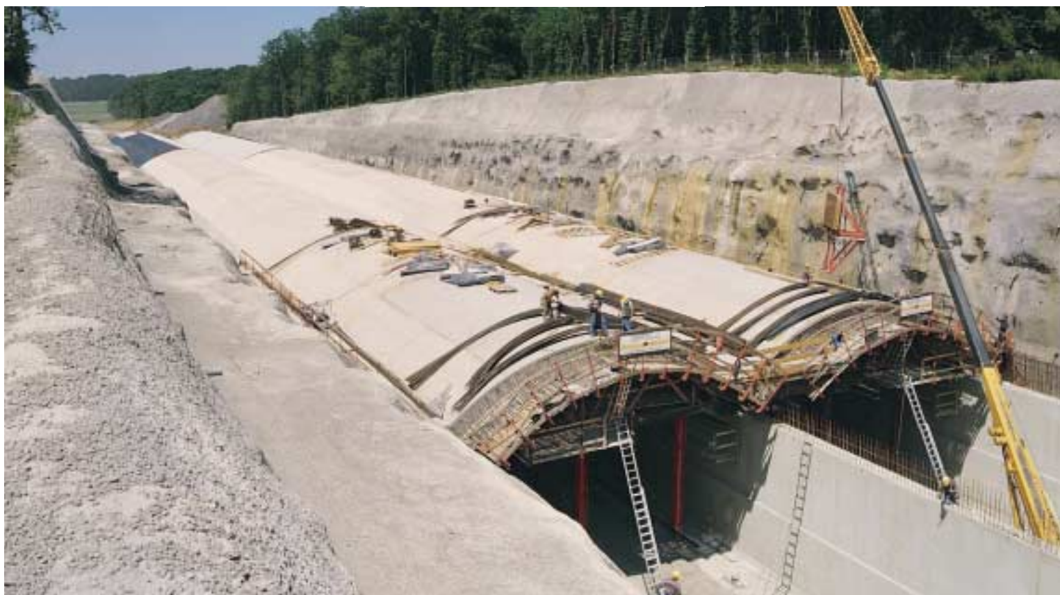
Veduta della sezione della galleria di lunghezza 275 m. Una volta ultimate, le due sezioni di galleria vengono coperte, ripristinando lo stato originario dei pendii del terreno.
