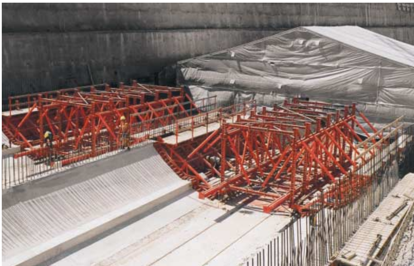
Utilizzando componenti di serie del sistema di orditure, le casseforme dell'arco rovescio realizzate su misura consentono eccellenti finiture superficiali del calcestruzzo e sezioni con dimensioni precise.
