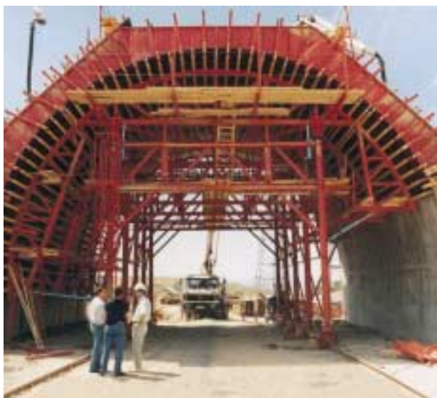
Il fermagetto frontale del troncone della galleria è stato realizzato con una cassaforma specifica.
