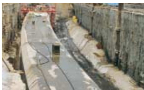
Gekrümmte Tunnelröhre kurz vor Fertigstellung.
