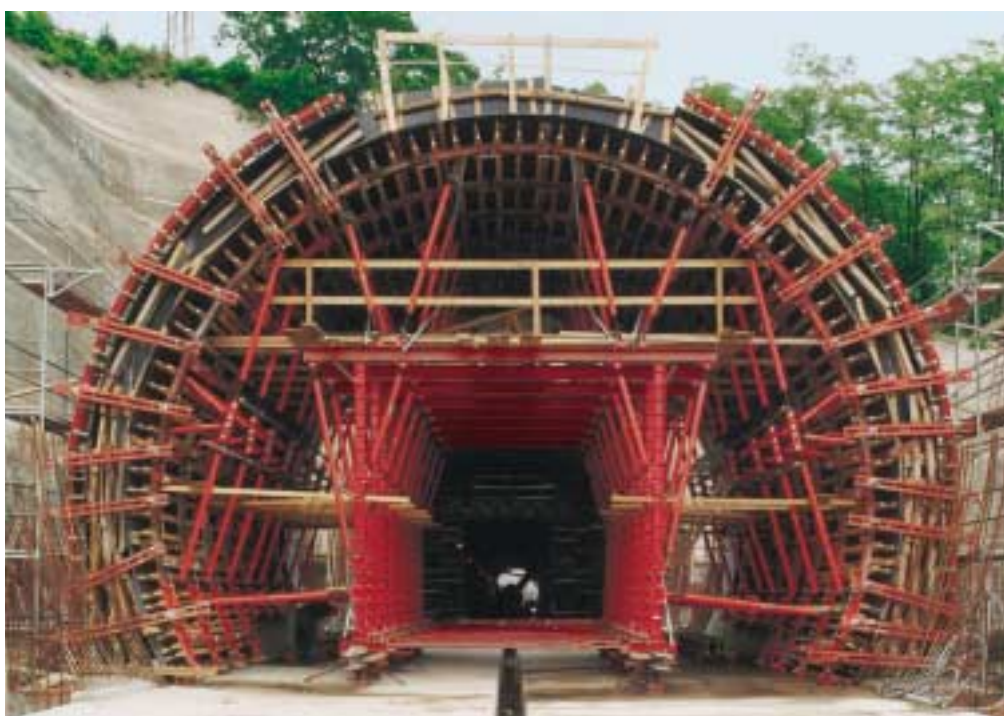
Sistema di telai d'orditure e correnti a snodo GRV per cassaforma di sezione policentrica semovente. Galleria Vranani, Repubblica Ceca
