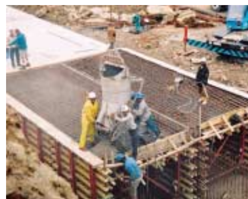
Fase di getto sezione Culvert 308.
