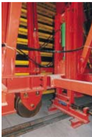
Con i dispositivi idraulici la cassaforma viene sollevata per la messa in opera o abbassata sulle ruote per la movimentazione.
