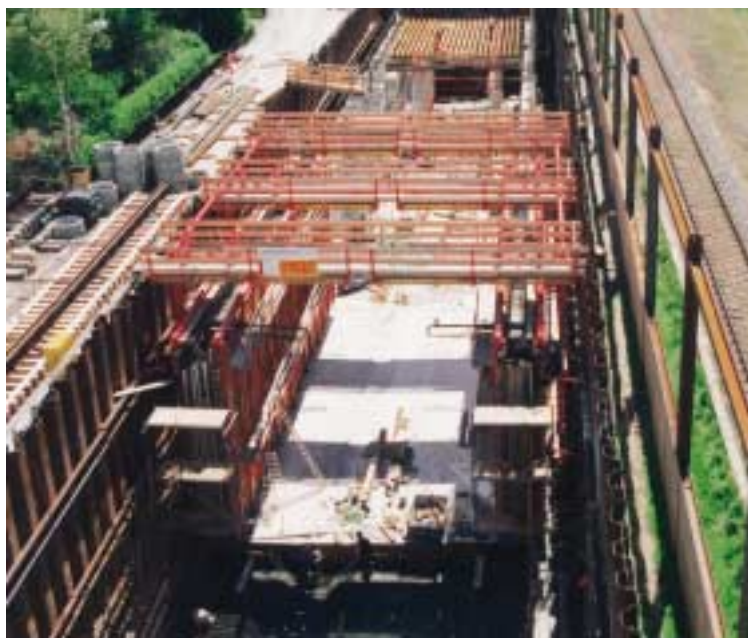
L'incastellatura a portale con appesi i moduli della cassaforma VARIO a travi per pareti.
