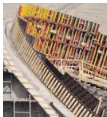
La finitura superficiale particolare di questo portale a collare (in alto a destra) è stata realizzata montando travetti sagomati in legno sul rivestimento di pannelli per cassaforma (vedi sotto).
