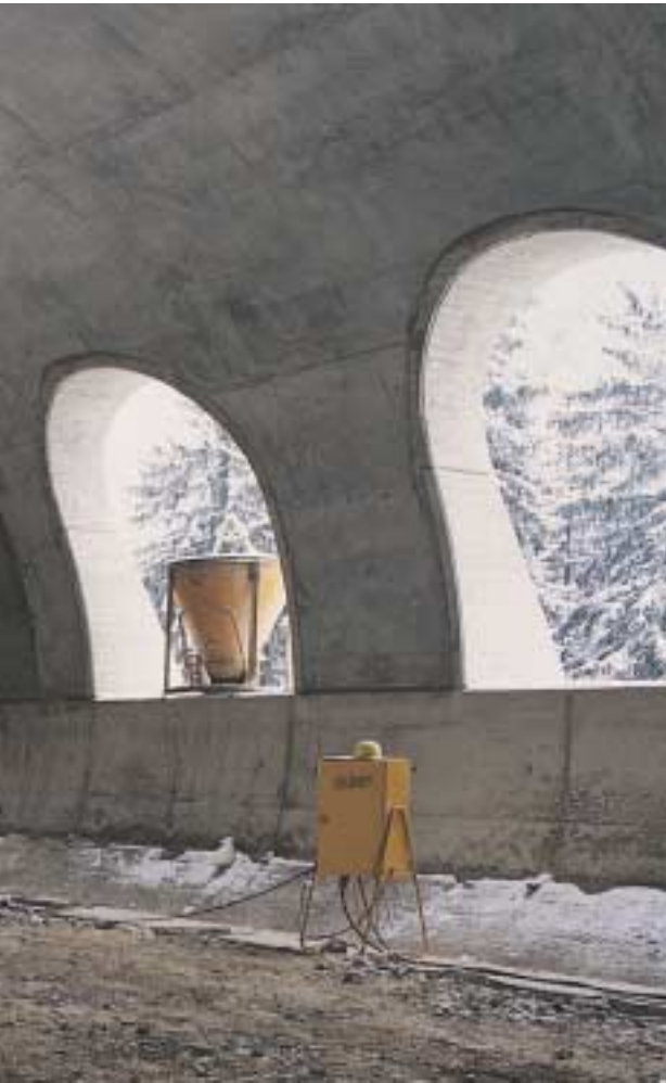
Vista della sezione ampliata con le aperture ad arco disposte sul lato a valle.
