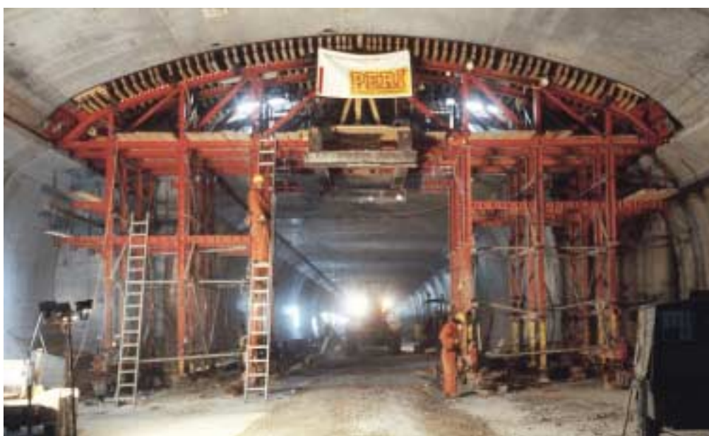
Cassaforma traslabile per copertura a volta realizzata sulla base del sistema di telai di orditure. Galleria di Eggflue, Svizzera
