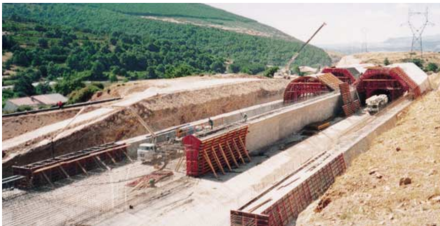
Il fermagetto frontale del troncone della galleria è stato realizzato con una cassaforma specifica.
