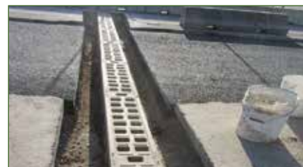
Il conglomerato viene rimosso in corrispondenza della trincea dove si alloggia il canale prefabbricato
