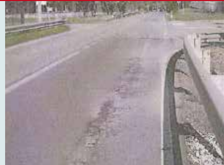
Febbraio 2014 - Sopralluogo - Dopo 7 mesi dal ripristino senza AUTOTENE ASFALTICO ANTIPUMPING
