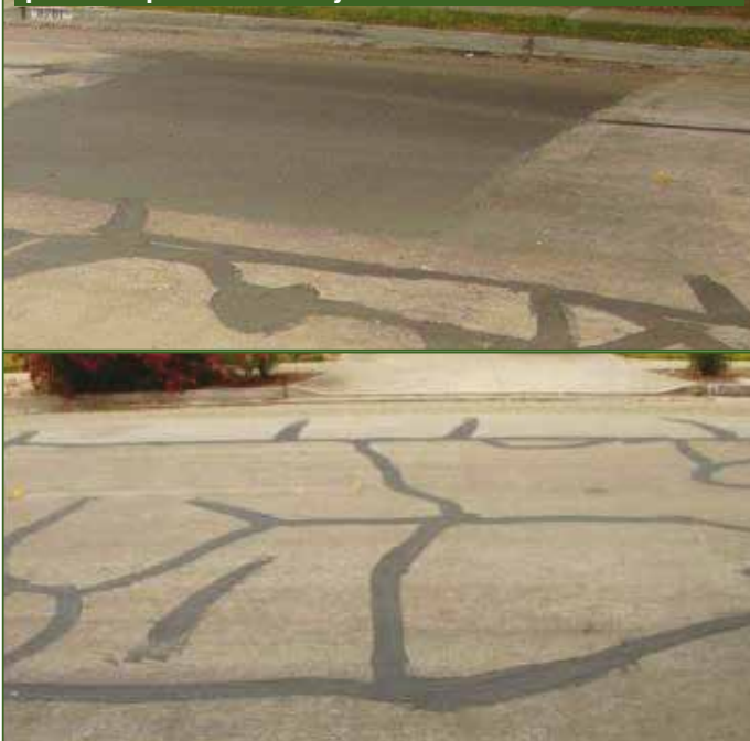
Opere di sigillatura a caldo in strade statunitensi prima della posa di un "Interlayer"
