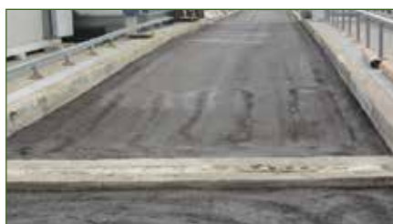
Le corsie sono attraversate da una trincea dove si alloggianno gli impianti
