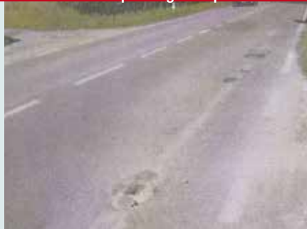
Febbraio 2014 - Sopralluogo - Dopo 7 mesi dal ripristino senza AUTOTENE ASFALTICO ANTIPUMPING
