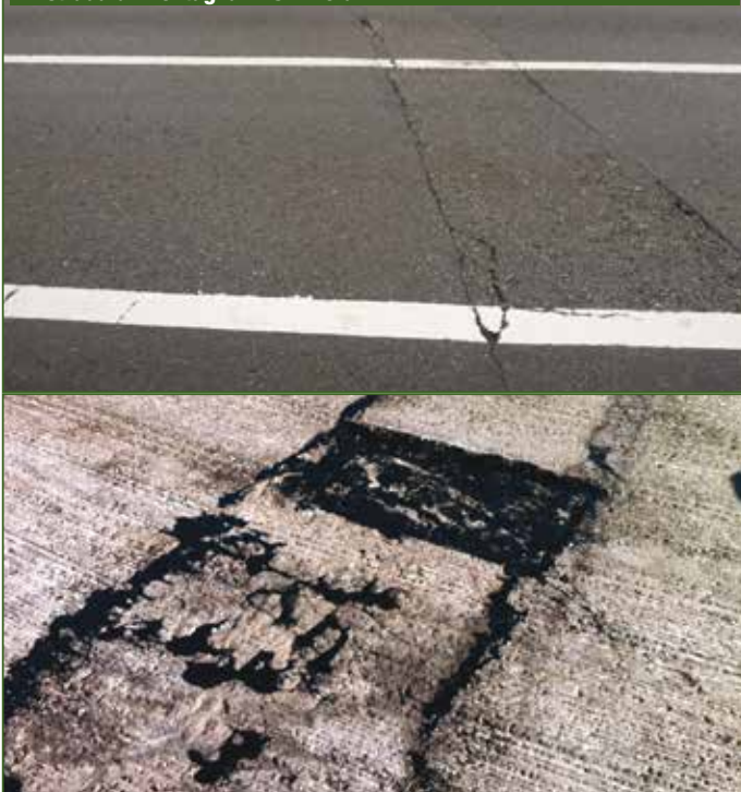
Opere di sigillatura delle fessure in strada di montagna in Svizzera
