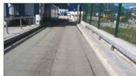
Stesura di AUTOTENE ASFALTICO ANTIPUMPING HE/TVP
