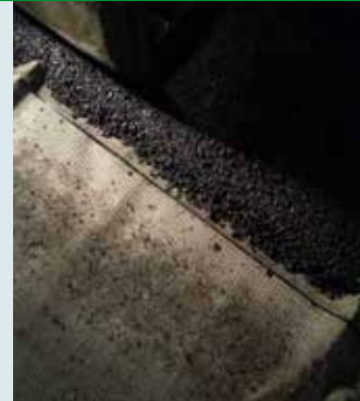
Agosto 2015 - Rifacimento con AUTOTENE ASFALTICO ANTIPUMPING
