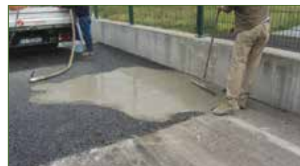
La saturazione delle porosità del conglomerato con una speciale malta cementizia ha lo scopo di aumentarne la portanza per sopportare il traffico pesante
