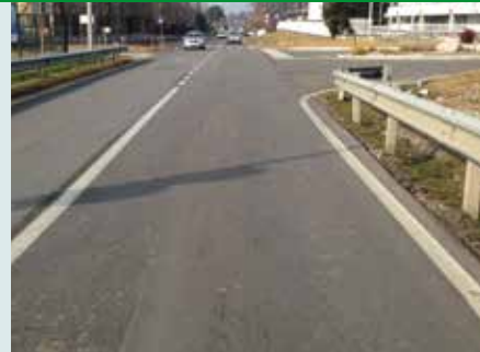
Febbraio 2017 - Sopralluogo - Dopo 34 mesi dal ripristino con AUTOTENE ASFALTICO ANTIPUMPING
