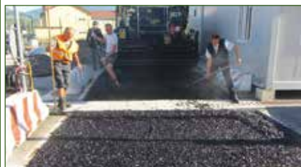
Stesura a caldo di un conglomerato aperto
