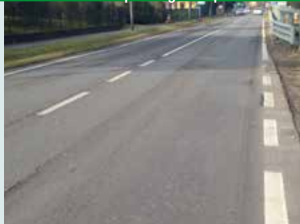
Febbraio 2017 - Sopralluogo - Dopo 34 mesi dal ripristino con AUTOTENE ASFALTICO ANTIPUMPING
