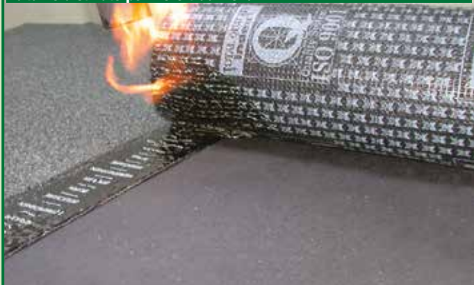
Posa a fiamma delle membrane impermeabilizzanti bitume distillato polimero tradizionali
