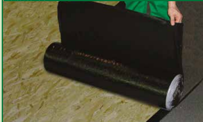
Posa a freddo per semplice pressione delle membrane autoadesive SELFTENE
