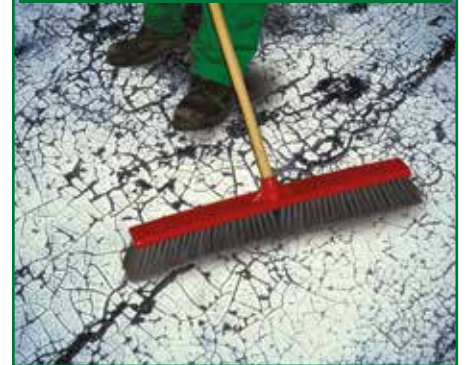
PULIZIA DEL MANTO BITUMINOSO
