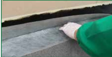
8. RIMOZIONE DEL NASTRO PROTETTIVO PRECEDENTEMENTE APPLICATO
