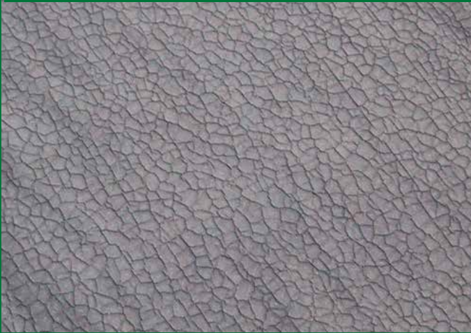
COCCODRILLATURA DI SUPERFICI BITUMINOSE ARDESiate PER ECCESSO DI SPESSORE DI BITUME SULL'ARMATURA, MA DOPO 30 ANNI IL MANTO È ANCORA A TENUTA D'ACQUA
