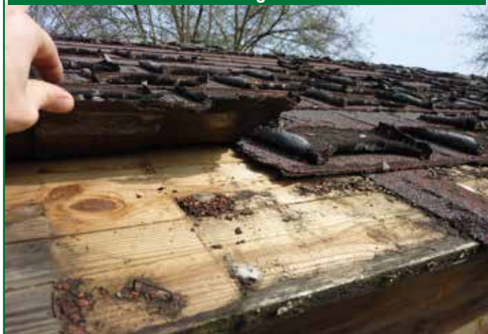
Prima: copertura con vecchie tegole bituminose
