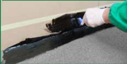
7. SECONDA MANO DI PURLASTIC FLASHING
