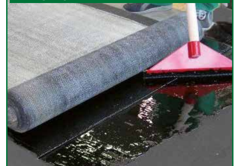
APPLICAZIONE DI FLEXTER TEX INCOLLATO CON MASTIPOL SU MANTO BITUMINOSO ARDESIATO
