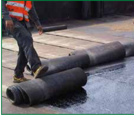
5. POSA DELL'ARMATURA RINFOTEX EXTRA
