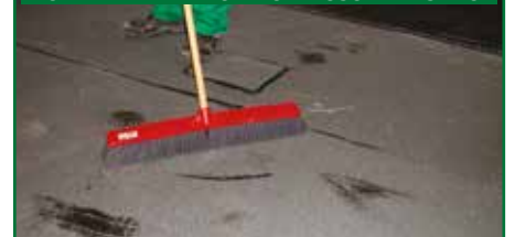
PULIZIA DEL MANTO BITUMINOSO ARDESIATO
