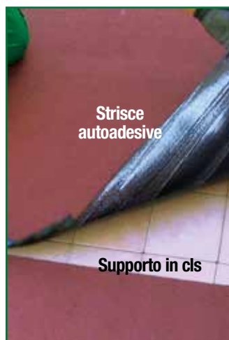
Rimozione del film siliconato
