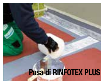
Posa di RINFOTEX PLUS
