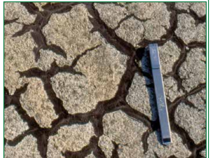
COCCODRILLATURA DI SUPERFICI BITUMINOSE ARDESiate PER ECCESSO DI SPESSORE DI BITUME SULL'ARMATURA, MA DOPO 30 ANNI IL MANTO È ANCORA A TENUTA D'ACQUA
