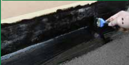
7. SECONDA MANO DI PURLASTIC FLASHING
