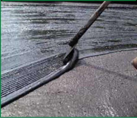
4. RISVOLTI IN VERTICALE. PRIMA MANO DI PURLASTIC FLASHING
