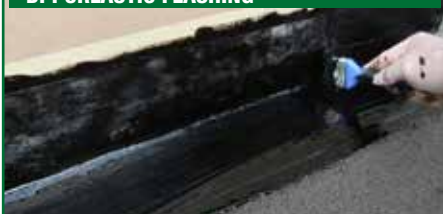
7. SECONDA MANO DI PURLASTIC FLASHING
