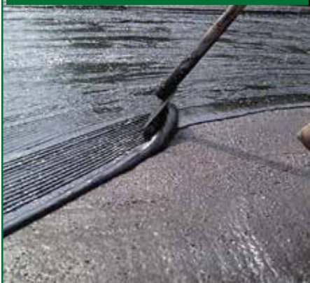
4. RISVOLTI IN VERTICALE. PRIMA MANO DI PURLASTIC FLASHING
