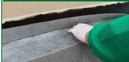
5. POSA DELL'ARMATURA RINFOTEX EXTRA
