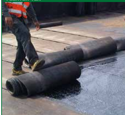
2. POSA DELLE MEMBRANE FLEXTER TEX
