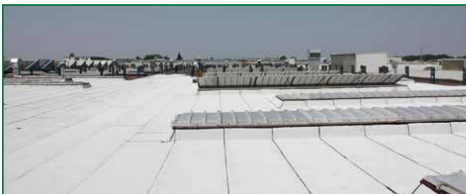
RIFACIMENTO DI COPERTURA CON MINERAL REFLEX WHITE
