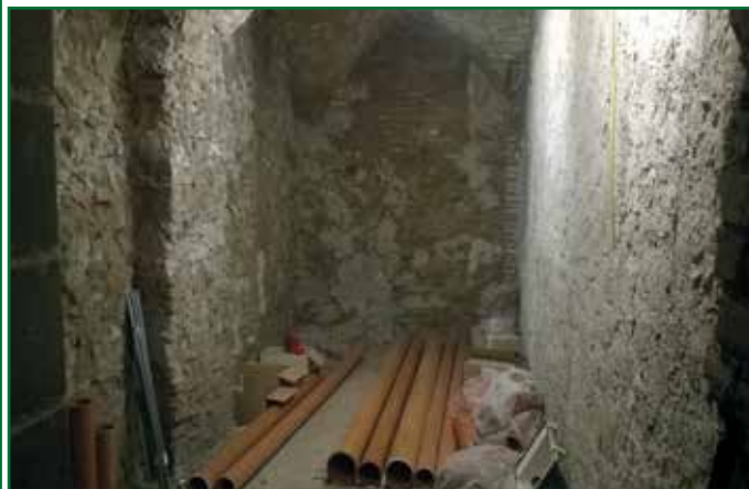
Disintonacatura
