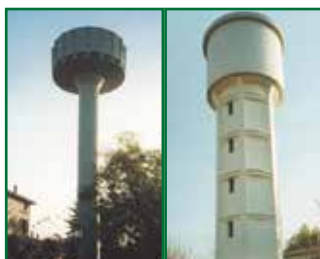
TORRI PIEZOMETRICHE Bologna - ITALIA
