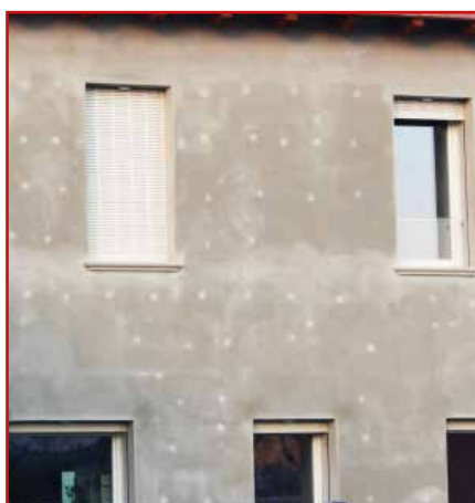
DISOMOGENEITÀ DI ASSORBIMENTO IGROMETRICO DOVUTO A SPESSORI NON COSTANTI DEL RASANTE
