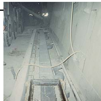
Posa in opera del PRATIKO nel Tunnel del Monte Bianco
