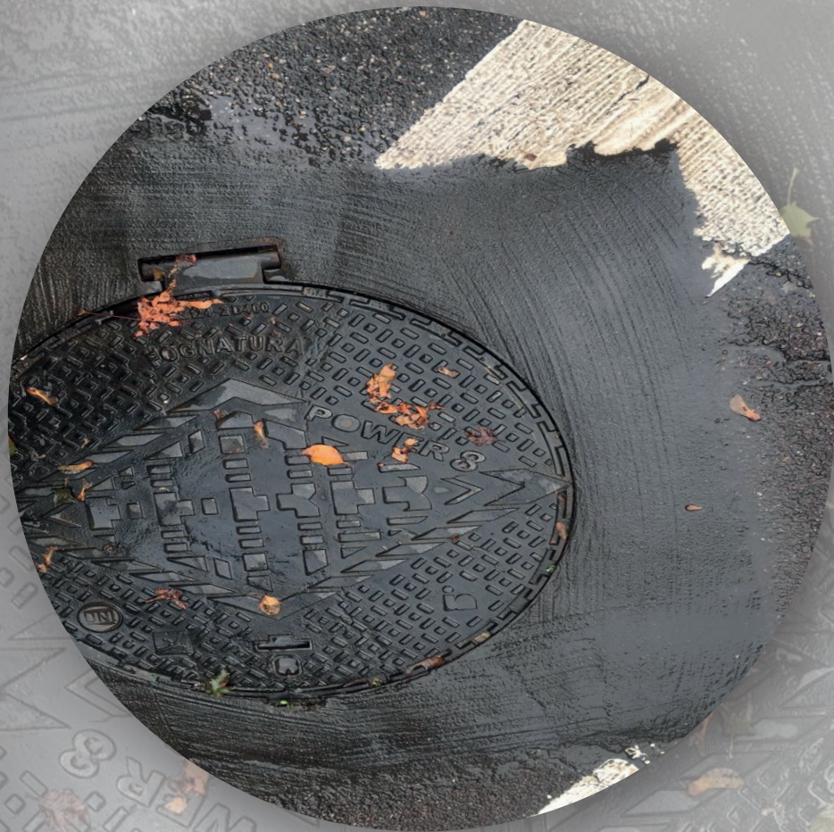
Chiusino posizionato e sigillato con malta rapida antiritiro RALLK
