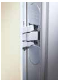
Particolare cerniera a scomparsa Concealed hinge detail
