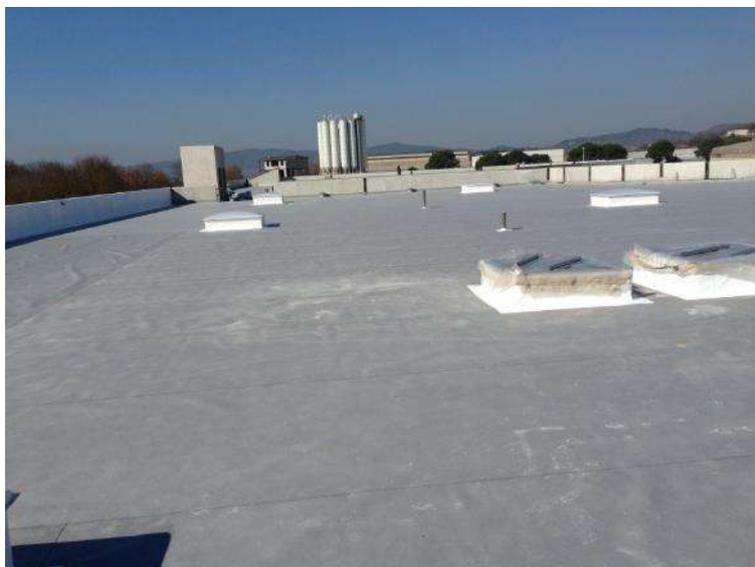
Isolamento solaio su autorimessa da ca. **24.000 mq** in completa sostituzione dell'isolante leggero tradizionale (XPS), con spessore di ca. **13 cm**
