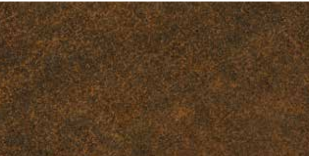
3. Aspecto/Tonalidad del acero corten despues de 12/18 meses desde la instalación.
