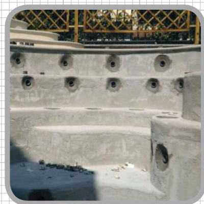
IMPERMEABILIZZAZIONE CORPO PASSANTE
