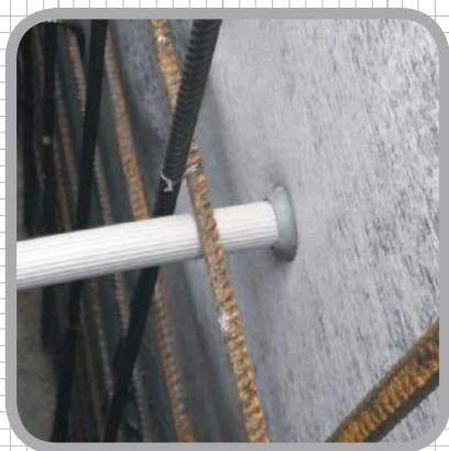
IMPERMEABILIZZAZIONE CORPI PASSANTI
