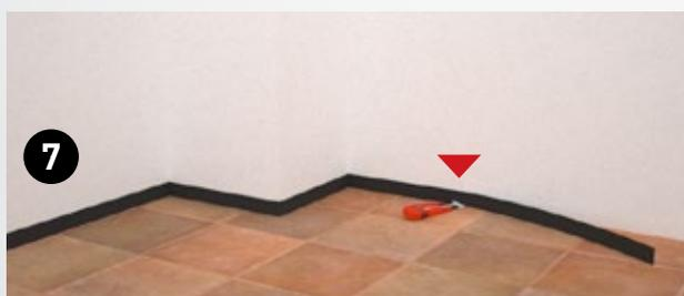
7 **Rifilo della fascia perimetrale:** la fascia perimetrale va rifilata solo dopo la posa e la stuccatura della pavimentazione e prima della posa del battiscopa.
