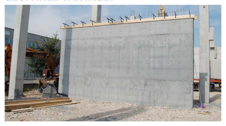
GEOPANEL è un sistema facile ed intuitivo di casseforme modulari in ABS per la realizzazione di murature, fondazioni e pilastri in calcestruzzo.
