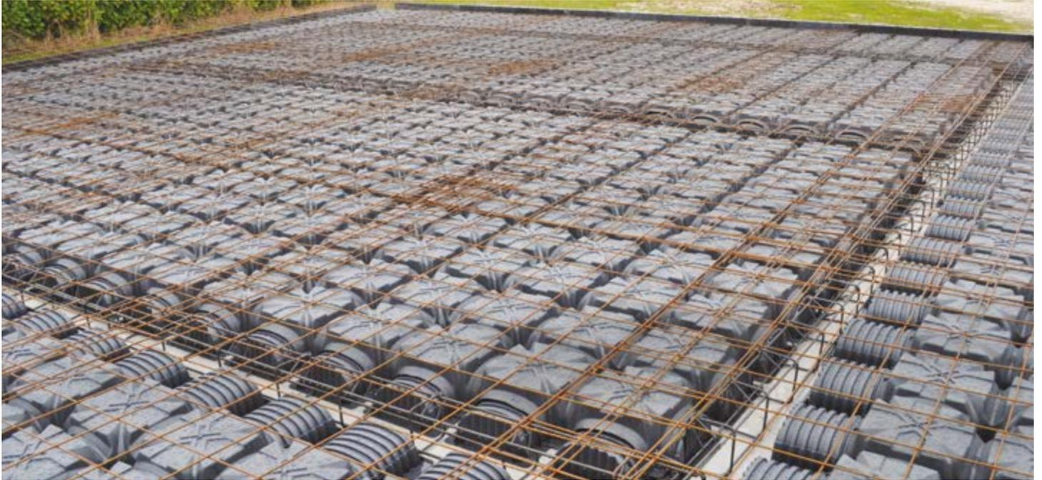
Il MODULO è un cassero a perdere che, opportunamente ventilato, permette l'eliminazione dell'umidità di risalita e del Gas Radon. Grazie alla sua particolare forma MODULO consente di ottenere una struttura in calcestruzzo armato composta da
