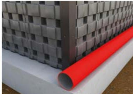
Posare un tubo che scarica in un bacino di drenaggio, lungo tutto il perimetro dell'edificio e vicino alla parete.
