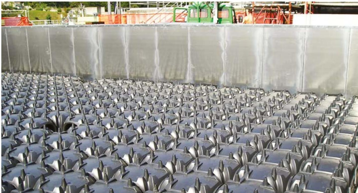
Cassero a perdere per la creazione di pavimentazioni perforate autoportanti per bio-filtri e sistemi per il trattamento aerobico dei rifiuti.
