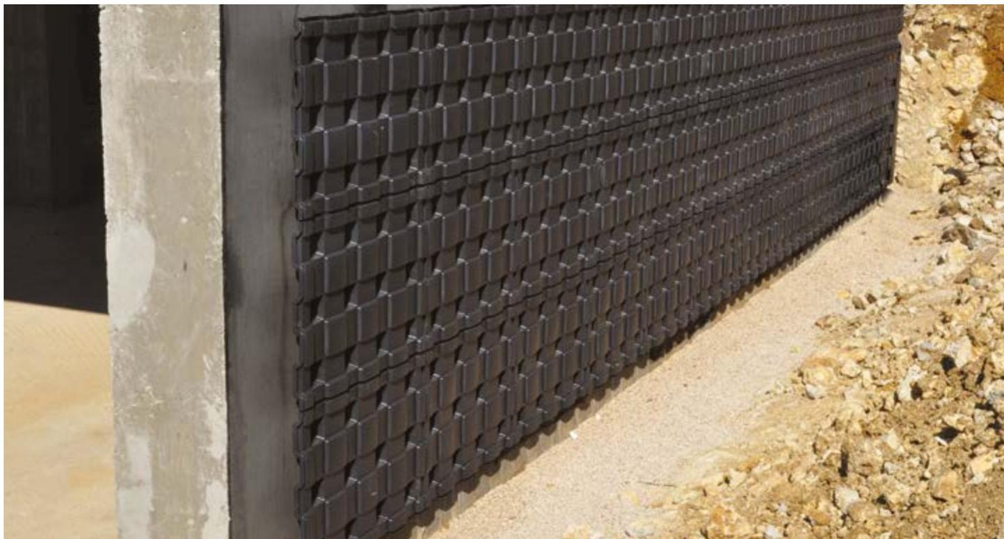
Unisce i vantaggi della guaina bugnata e della ghiaia in un unico prodotto, proteggendo maggiormente l'impermeabilizzazione e ventilando il muro interrato.
