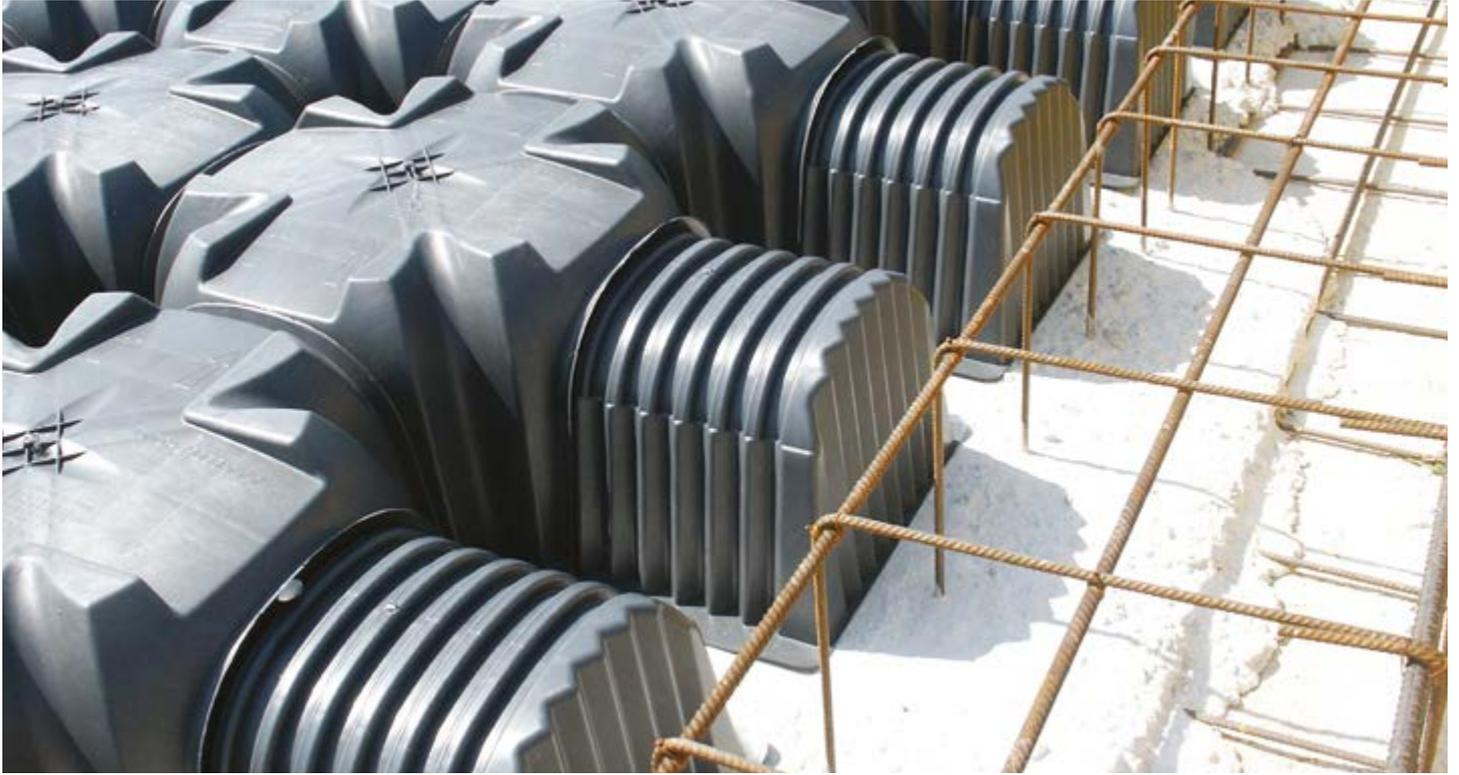
Cassaforma modulare per fondazioni ventilate e per la creazione di una barriera fisica tra il terreno e l'edificio.
