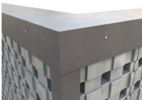
Posizionare il foglio di cartonplastico sopra a DEFENDER e fissarlo con le viti autofilettanti (nel caso di altri materiali utilizzare collanti con analoga funzione).
