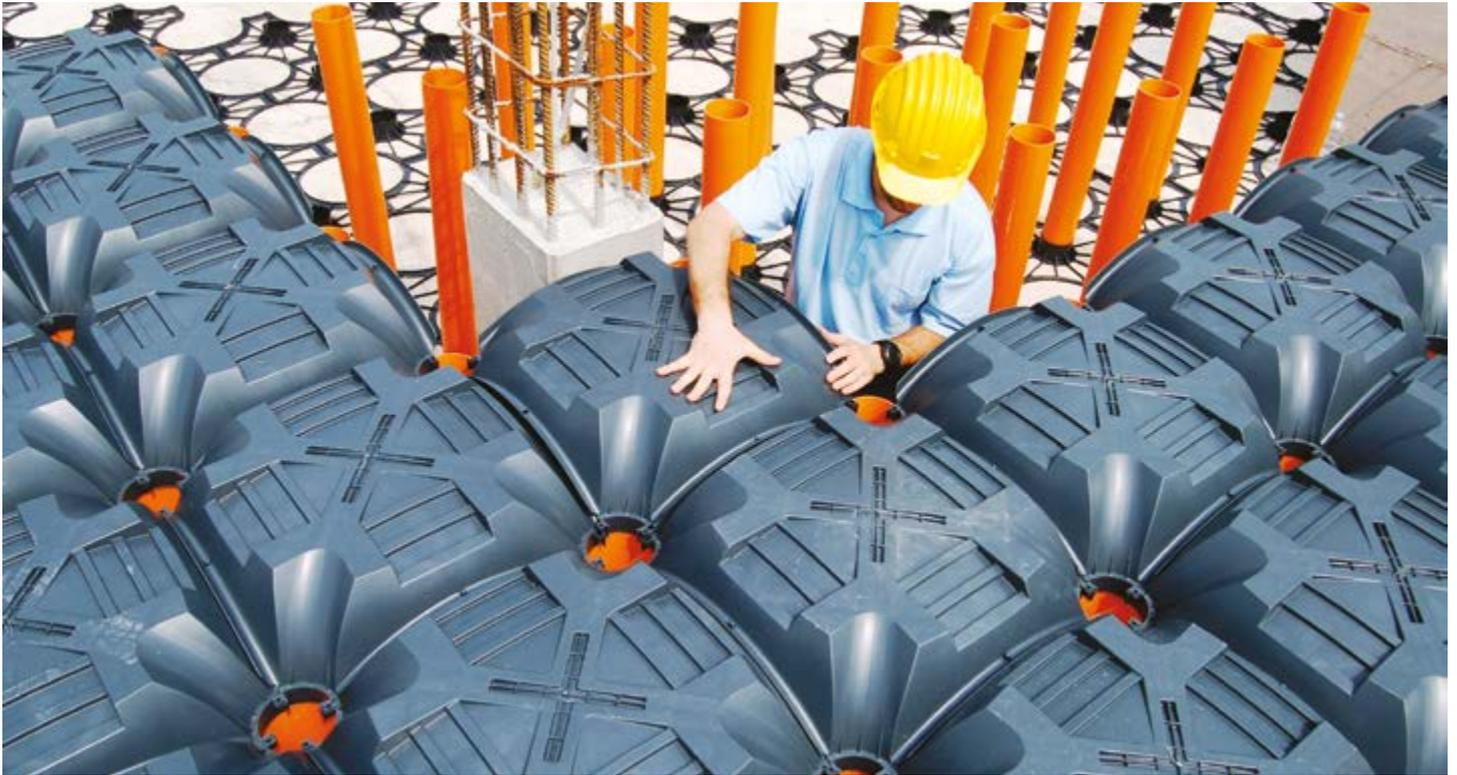
Sistema modulare e monouso per fondazioni ventilate fino a 300 cm di altezza per la creazione di una barriera fisica tra il terreno e l'edificio.
