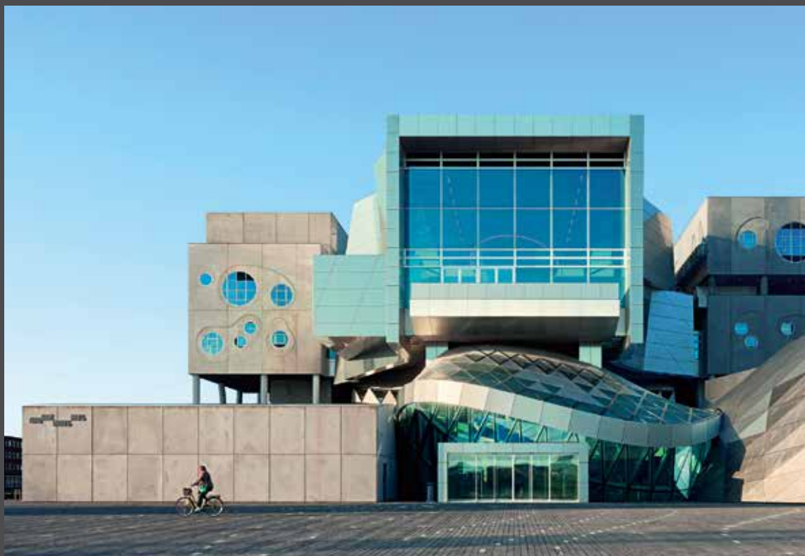
La facciata in pannello composito ALUCOBOND® PLUS naturAL Brushed conferisce all'edificio il suo carattere distintivo. | Fotografia: Duccio Malagamba
