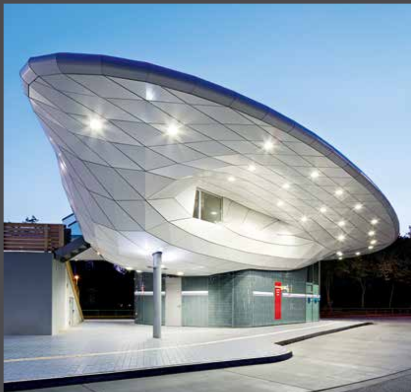
Copertura galleggiante a forma alare della stazione autobus Poppenbüttel, realizzata in ALUCOBOND® PLUS Pure White. | Fotografia: archimages
