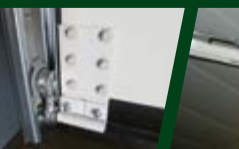
Paracadute cavi (Pegaso Line) Cable break safety device Seilbruchsicherungsrichtung
