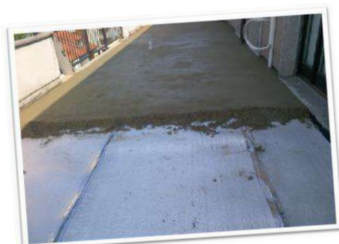
Isolamento termico sottile sottopavimento di coperture piane in Condominio, Novara
