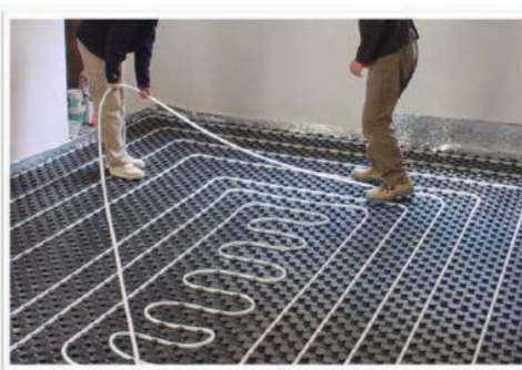
Isolamento termico sottile e riflettente soluzione sotto riscaldamento radiante
