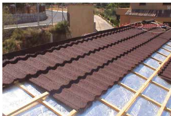
Copertura con manto di tegole
