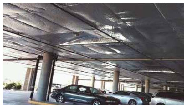
Isolamento piano pilotis su parcheggio
