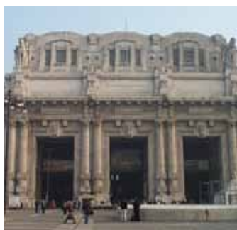
Stazione TAV – Milano Centrale, Italia
