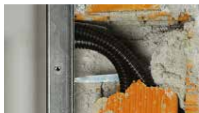
Ingresso laterale per tubi corrugati.
