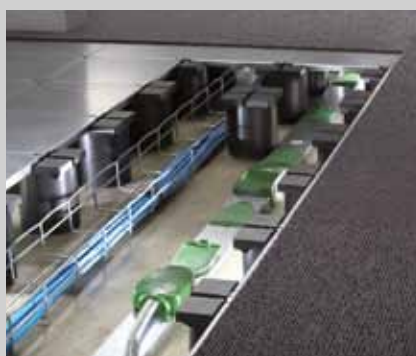
2 SISTEMA DI CANALIZZAZIONE SOTTOPAVIMENTO
