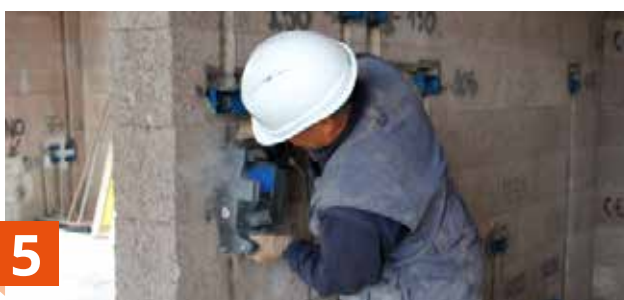
5 Realizzazione di tracce con la scanalatrice
