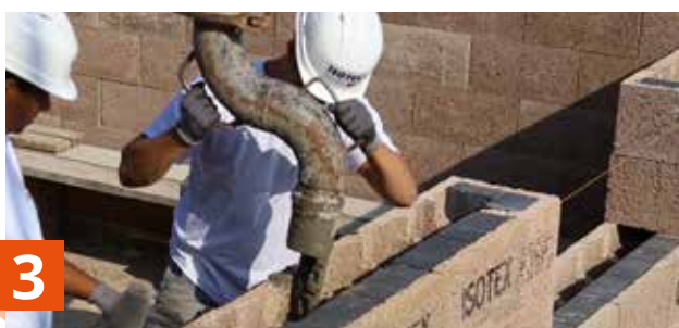
3 Riempimento del calcestruzzo nei blocchi (ogni 6 corsi)
