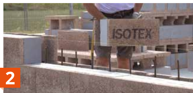
2 I corsi successivi si posano a secco
