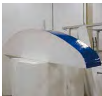
Casseforme per getti di architravi curvilinee in calcestruzzo
