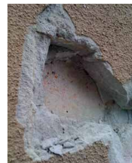
Cedimento di intonaco non idoneo all'incollaggio di un rivestimento
