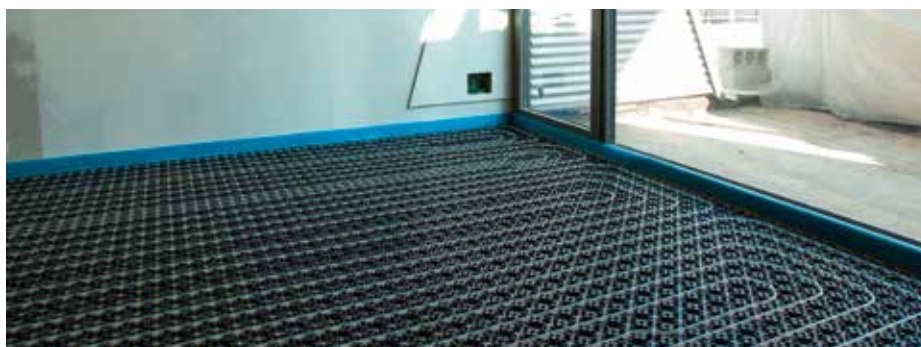
Sottofondo con impianto radiante a pavimento
