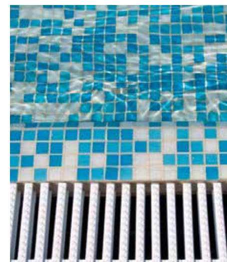
Esempio di punto critico del sistema impermeabilizzante in piscina e dettaglio di corretta esecuzione
