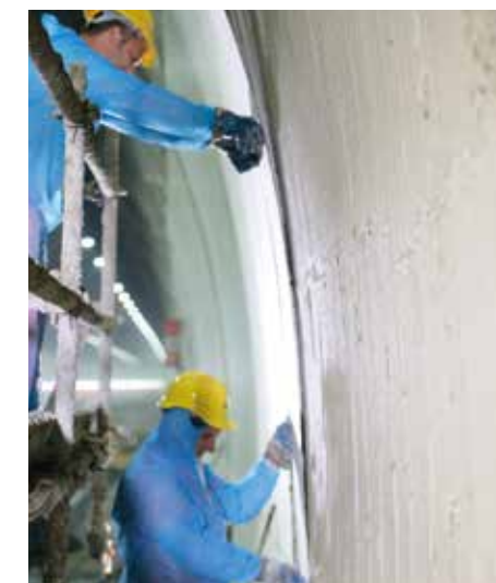
Messa in opera della lastra sul piedritto della galleria
