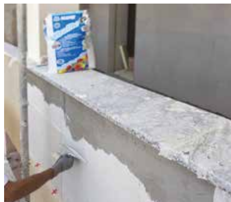
Stesura dell'adesivo sul supporto
