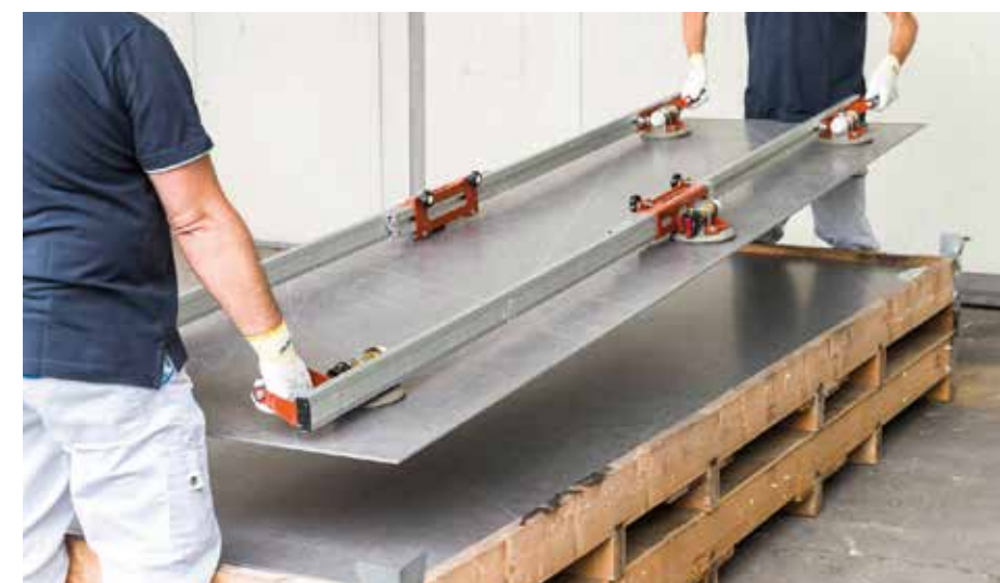
Movimentazione di lastre mediante l'utilizzo di specifici strumenti dotati di ventose
