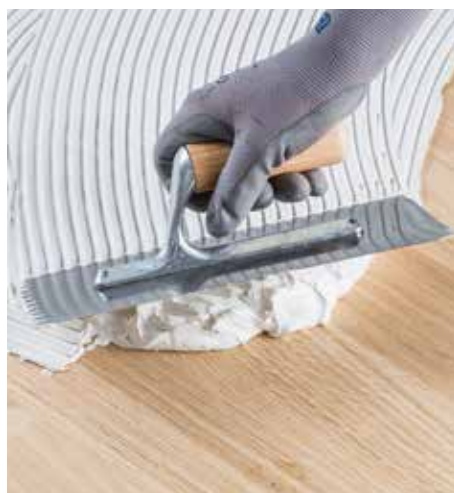
Posa di ceramica su pavimentazione in legno
