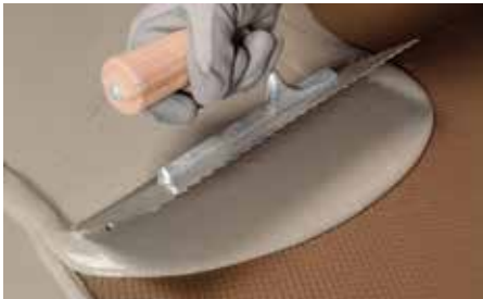
Applicazione di MAPELASTIC TURBO
