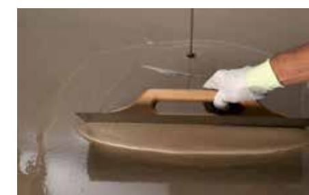
Applicazione di rasatura autolivellante
