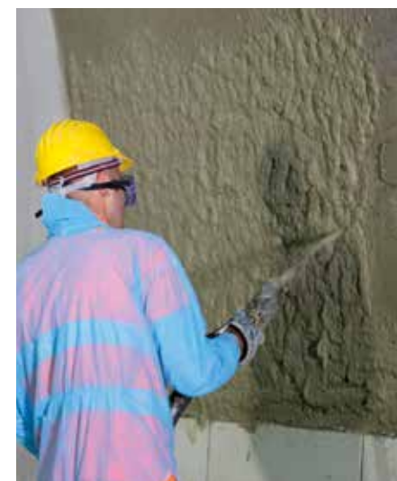
Applicazione a spruzzo dell'adesivo sul supporto di posa
