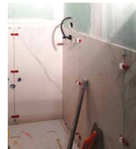
Posa di rivestimenti su pannelli in cartongesso
