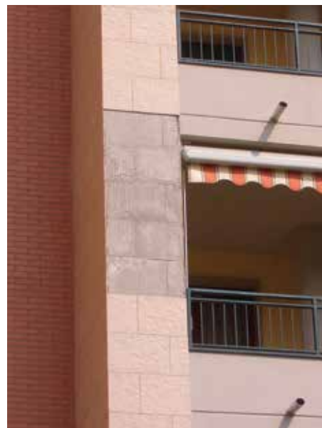
Distacco di rivestimento posato senza la realizzazione di giunti
