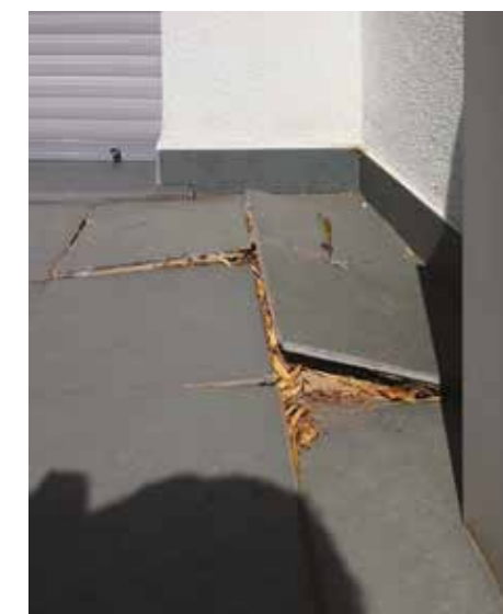
Fenomeni di distacco per compressione su pavimentazioni esterne dovute a mancanza di giunti
