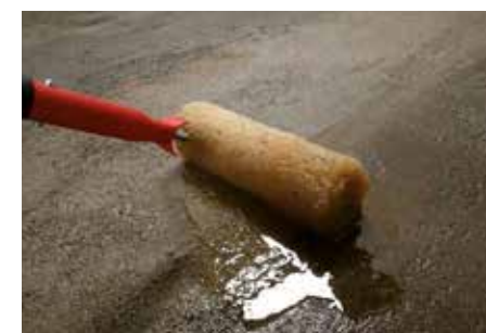
Applicazione di primer impermeabilizzante su sottofondo umido
