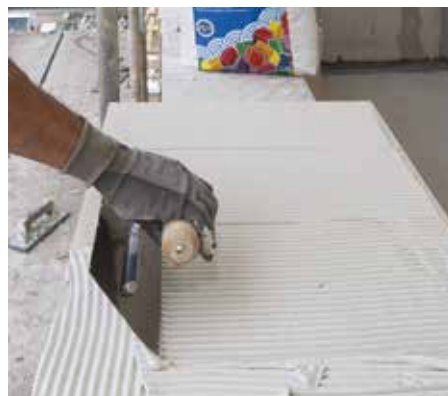
Stesura su adesivo su retro piastrella
