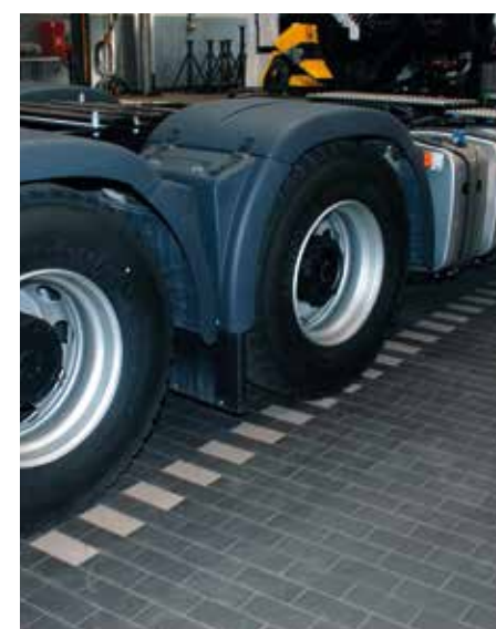
Pavimentazione sottoposta a carichi dinamici
