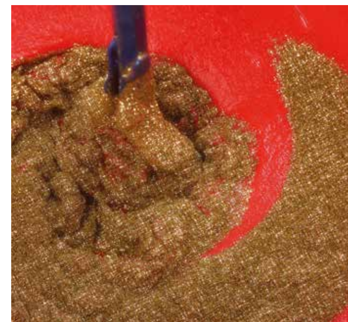
Miscelazione di KERAPOXY DESIGN con MAPEGLITTER
