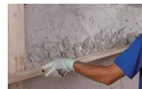
Applicazione di intonaco
