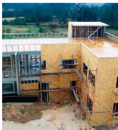
Struttura realizzata con pannelli in OSB
