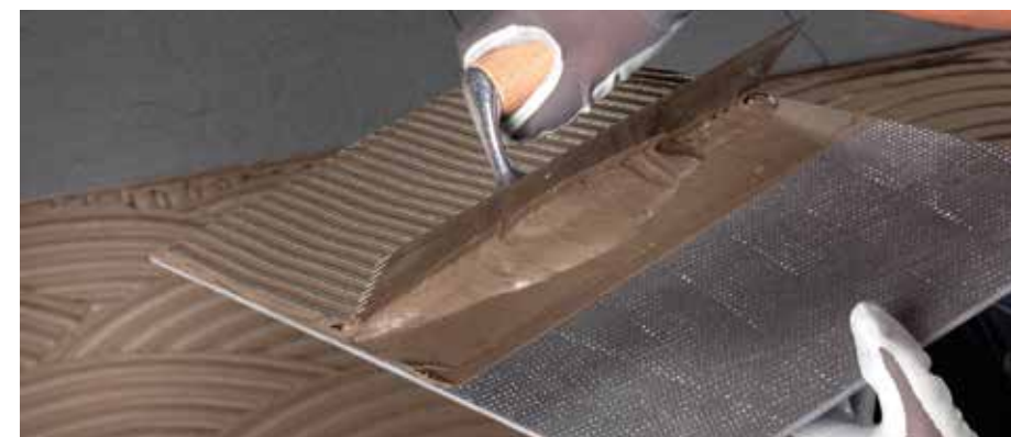
Posa di piastrelle sottili con tecnica della doppia spalmatura
