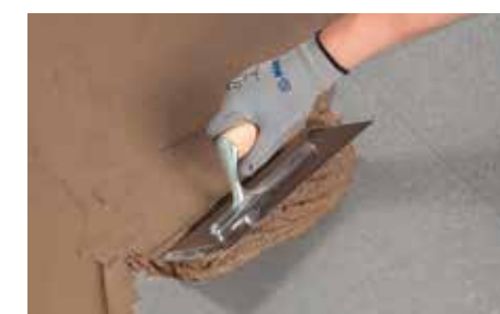
Applicazione di rasatura tissotropica a pavimento
