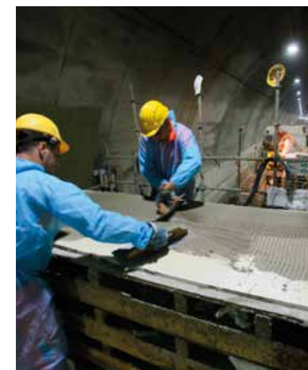
Stesura dell'adesivo sul retro delle lastre
