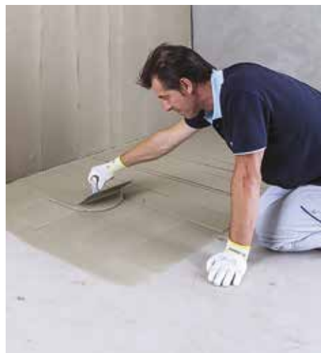
Doppia spalmatura della lastra sottile
