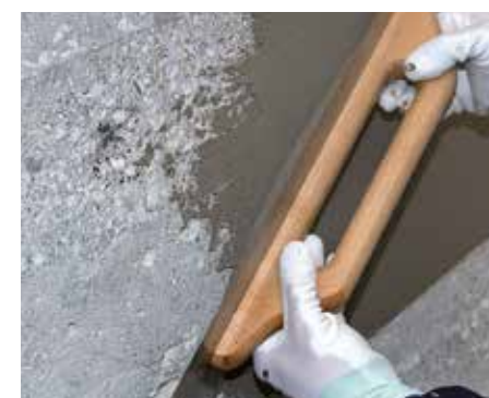
Applicazione di rasatura tissotropica a parete
