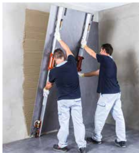
Movimentazione lastre sottili
