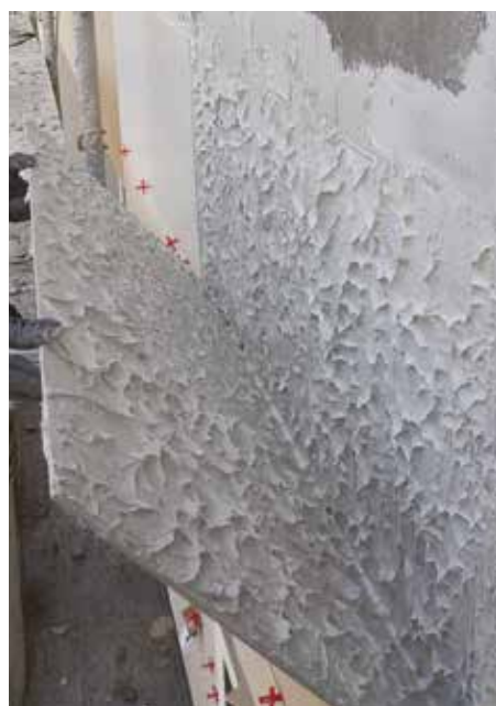
Verifica della completa bagnatura della lastra
