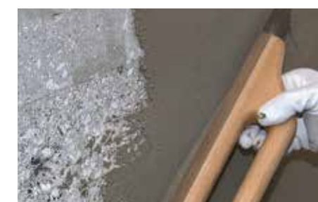
Applicazione di rasatura tissotropica a parete
