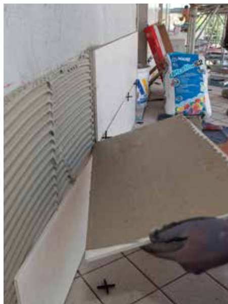
Posa corretta in facciata con metodo della doppia spalmatura
