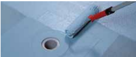
Stesura a rullo di MAPELASTIC AQUADEFENSE
