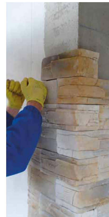
Posa di rivestimento con effetto “faccia a vista”
