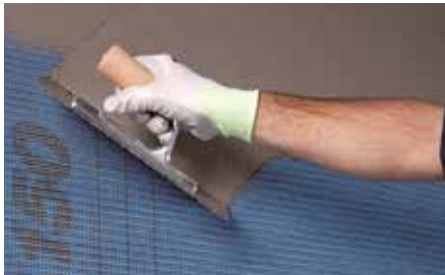
Applicazione di MAPELASTIC
