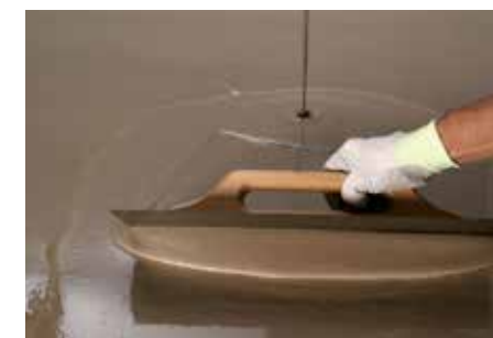
Applicazione di lisciatura autolivellante
