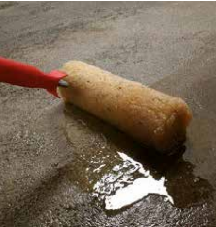
Applicazione di primer consolidante-impermeabilizzante
