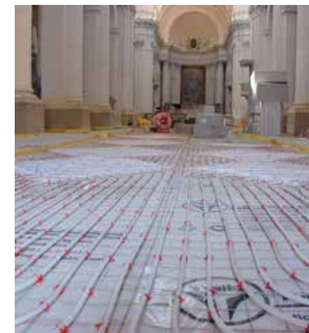
Installazione di tubazioni di un impianto radiante
