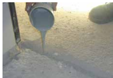
Sigillatura di fessure del sottofondo con EPORIP
