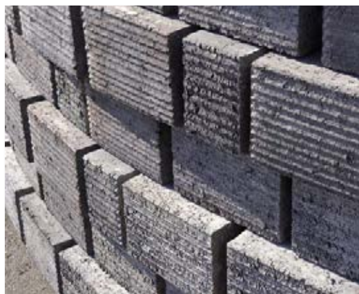
▲ Muro verticale a blocchi interi
