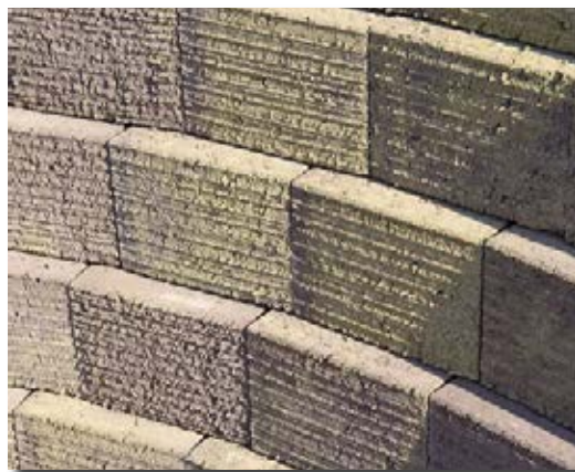
▲ Muro inclinato a blocchi interi con curva concava
