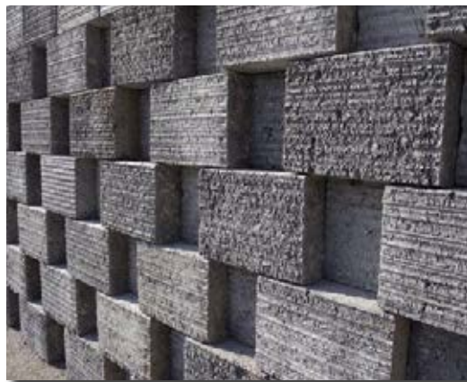
▲ Muro verticale a blocchi misti
