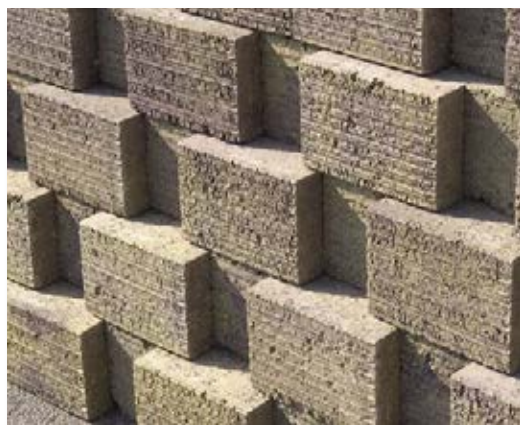
▲ Muro inclinato a blocchi misti
