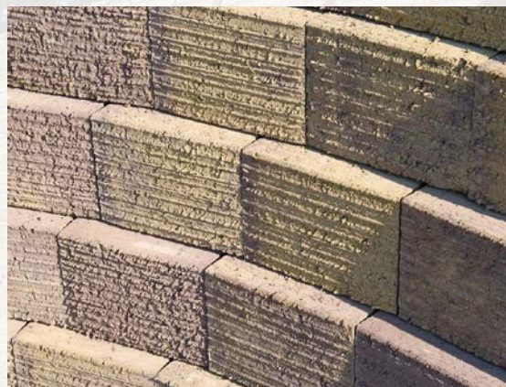
▲ Muro inclinato a blocchi interi con curva concava
