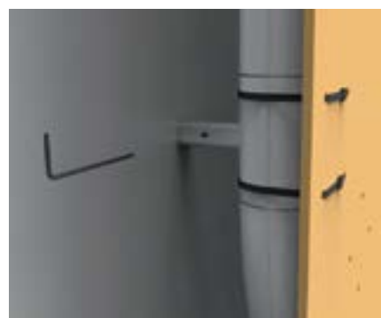
6. Particolare del fissaggio dei perni a parete.
