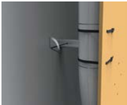
7. Particolare del fissaggio dei perni a parete.
