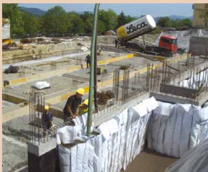
Isolamento termico di pareti verticali interraste con il sistema TermoBag.
