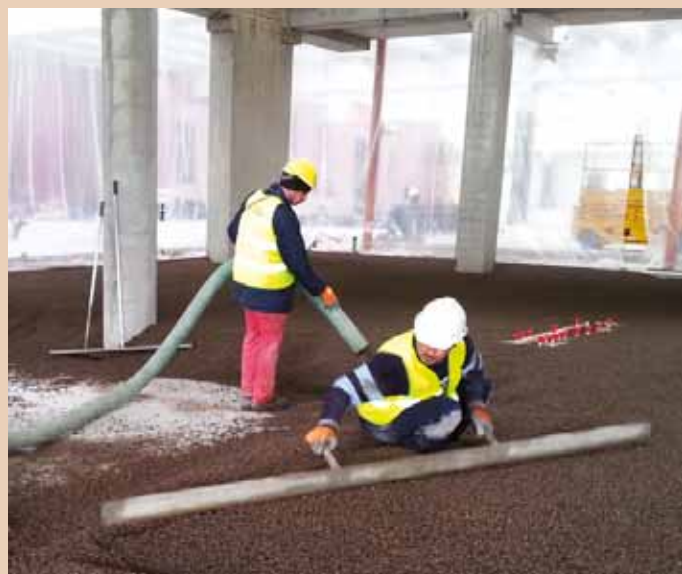
Stesura e staggiatura del vespaio isolato in Leca TermoPiù sfuso.
