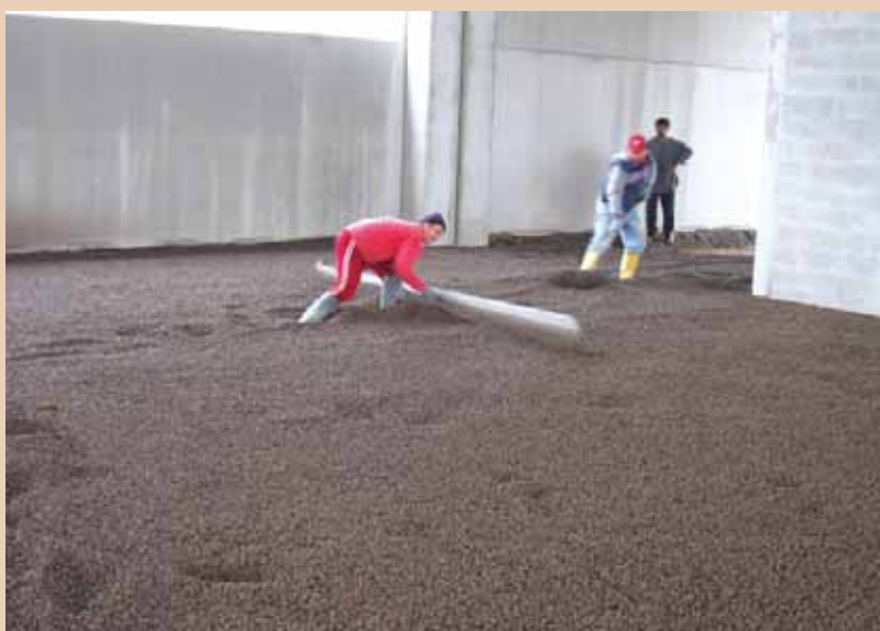
Staggiatura del vespaio isolato in Leca TermoPiù sfuso.
