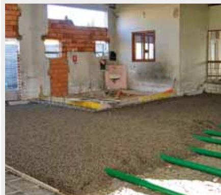
Eventuale tubazione di aerazione nel vespaio isolato in argilla espansa.
