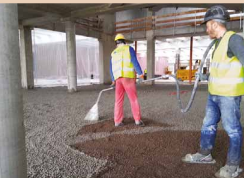
Imboiaccatura del vespaio in Leca TermoPiù.
