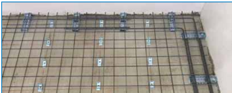
PERIMETRO FORTE: cerchiatura perimetrale realizzata da Connettore Perimetrale, Ancorante Chimico e dalle barre di armatura longitudinali.
