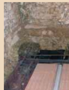
PERIMETRO FORTE: cerchiatura perimetrale realizzata da Connettore Perimetrale, Ancorante Chimico e dalle barre di armatura longitudinali.
