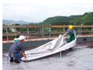
3 Fase: bloccaggio del telo
