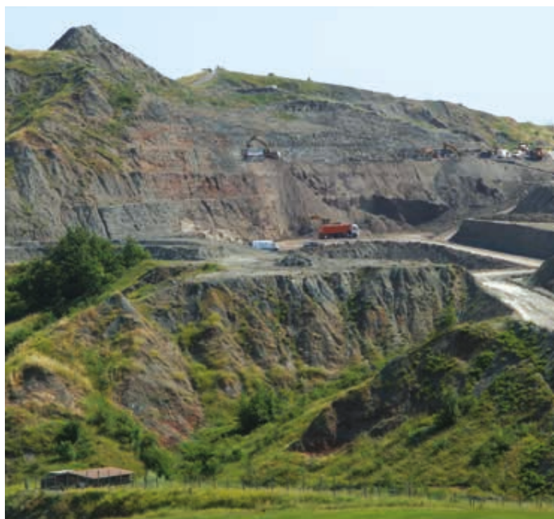
Fase di escavazione (cava Laterlite di Rubbiano).
