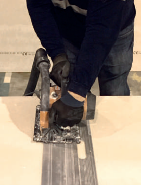
Taglio lastre in gesso fibrato con sega circolare
