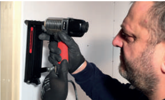
Avvitatura/Graffatura su struttura in legno
