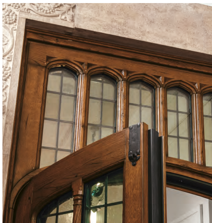
— Il nuovo portale al suo posto. The new door in its place.
