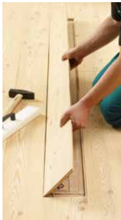
Sostituzione di una tavola.
