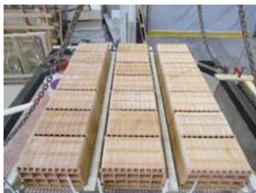
REALIZZAZIONE DEL SOLAIO
