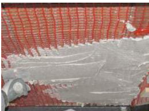
APPLICAZIONE DELL'INTONACO STRUTTURALE
