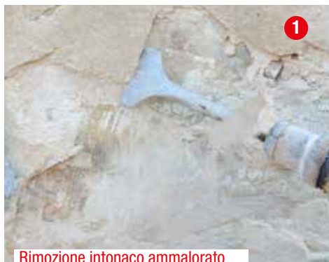
Rimozione intonaco ammalorato
