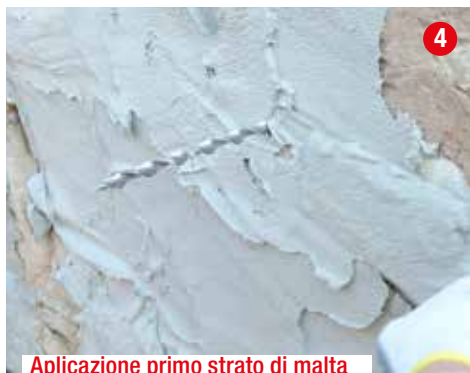
Applicazione primo strato di malta
