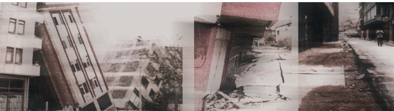
Esempi di rotture per superamento della capacità portante di fondazioni superficiali ad Adapazari (Turchia)
