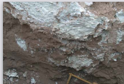
Espansione della resina nell'area circostante il punto di iniezione
