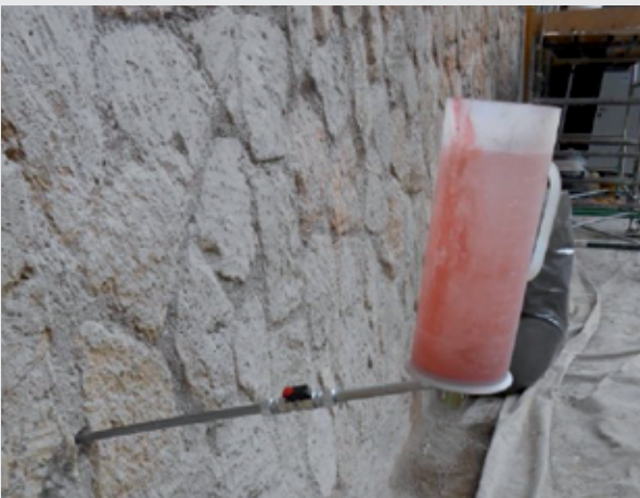
Terreno di fondazione oggetto d'intervento Uretex Deep Injections®
