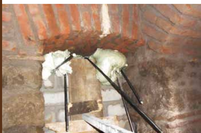
Iniezione della resina
