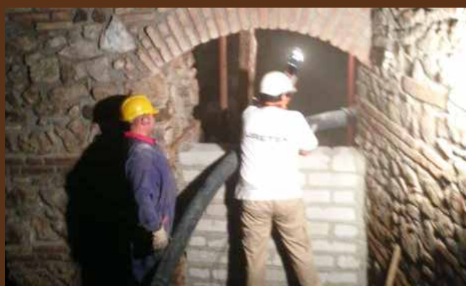
Riempimento con argilla espansa
