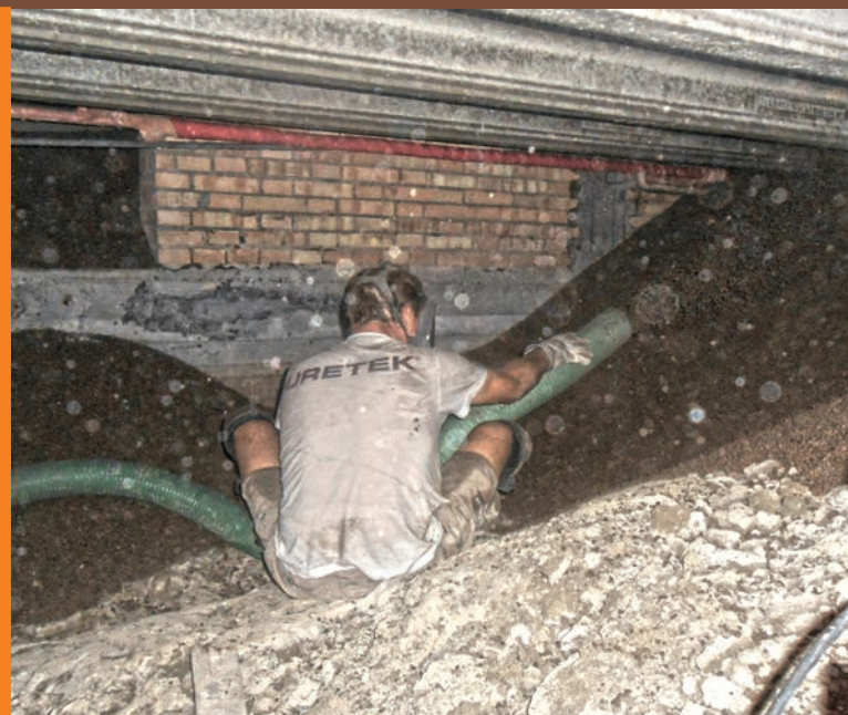
Fase di pompaggio dell'argilla
