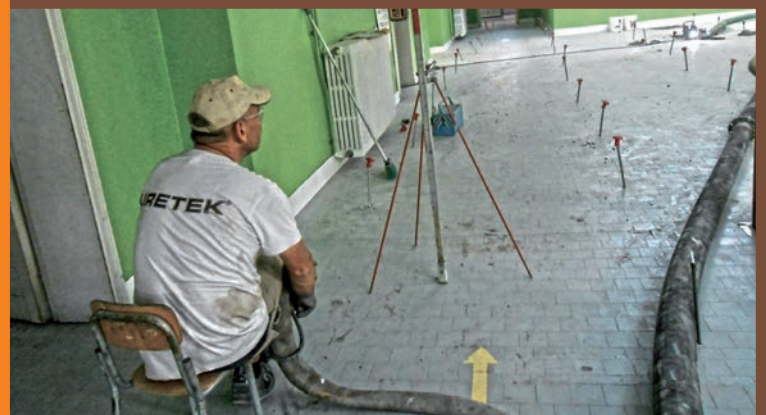
Fase di iniezione della resina
