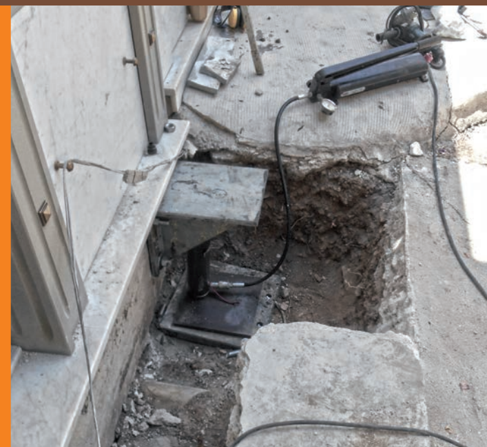
Posizionamento del martinetto
