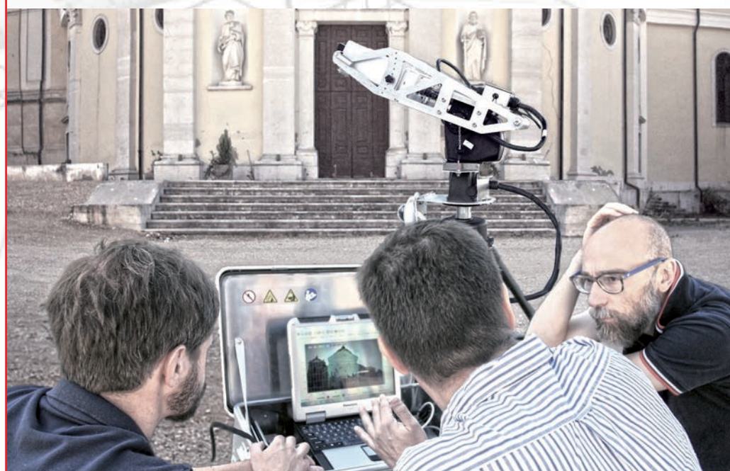
Sopra: URETEK DEEP INJECTIONS ULTRA® all'opera presso la chiesa di Marano di Valpolicella in provincia di Verona.
