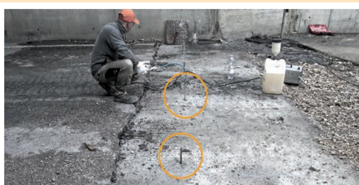
Sigillatura dei giunti orizzontali
