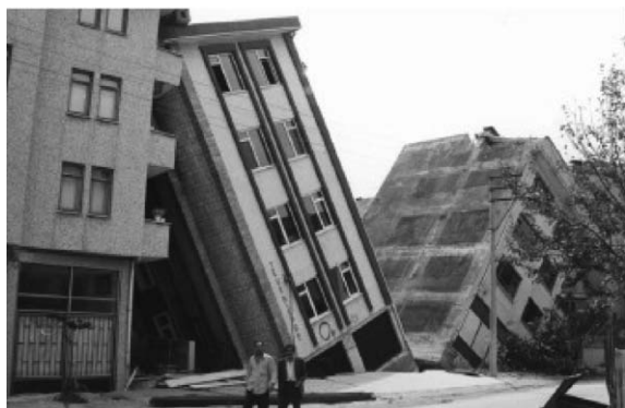
FIGURA 1. ESEMPI DI ROTTURE PER SUPERAMENTO DELLA CAPACITÀ PORTANTE DI FONDAZIONI SUPERFICIALI AD ADAPAZARI
