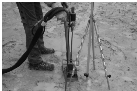
FIG. 17: ESECUZIONE DI UN'INIEZIONE CON CONTEMPORANEA ESTRAZIONE DEL CONDOTTO D'IMMISSIONE.
