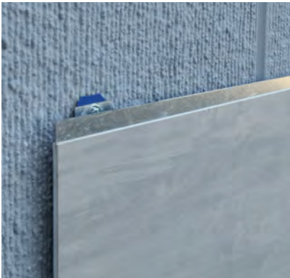
Regolare il pannello di partenza allineando sia il piano che la profondità (utilizzare spessori sul retro delle staffe per regolare eventuali fuori piombo della muratura) Adjust the starting panel aligning both the plane and the depth (use shims on the back of the brackets to adjust any lead out of the masonry)
