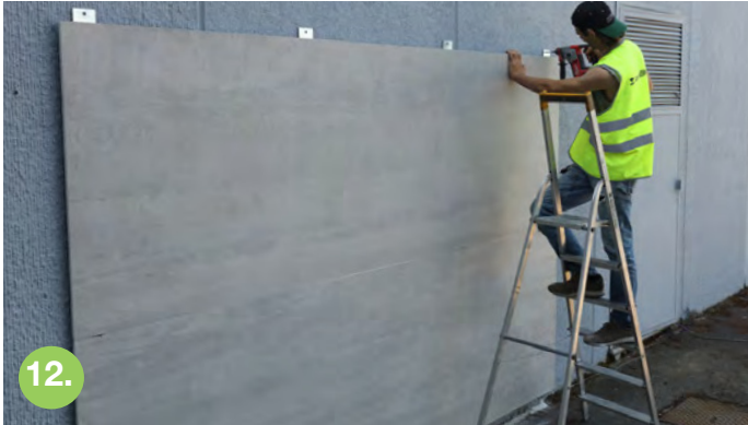
Forare in corrispondenza delle staffe del pannello superiore Drill in correspondence of the top panel brackets
