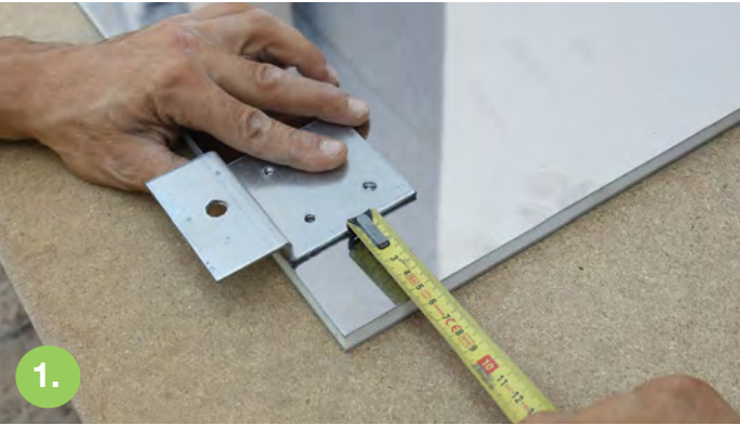
Posizionare la staffa a filo pannello ed a 5 cm (2") dal bordo laterale
