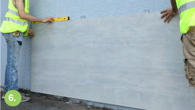
Posizionare il pannello in corrispondenza del muro avendo cura di controllare l'allineamento della fuga verticale Place the panel at the wall, taking care to check the alignment of the vertical grout line
