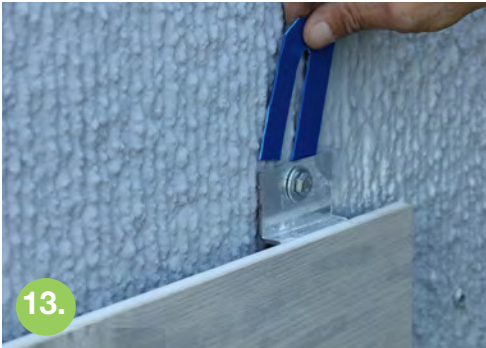
Applicare spessori sul retro delle staffe per regolare eventuali fuori piombo della muratura Apply shims on the back of the brackets to adjust any lead out of the masonry
