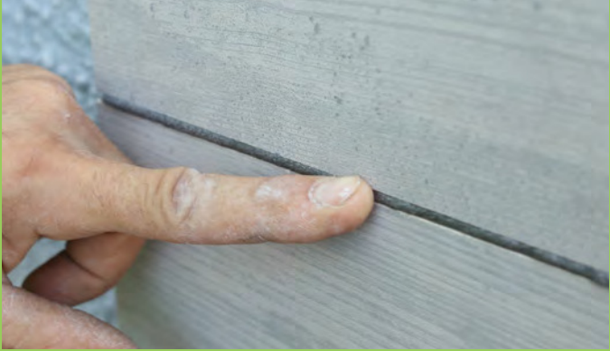
Inserire cordoncino di schiuma polietilenica estrusa del diametro adatto alla larghezza della fuga solo sulle fughe dove non è presente barra kerf
