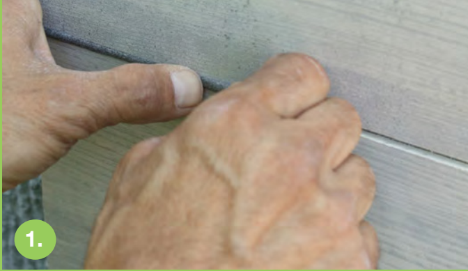
Inserire cordoncino di schiuma polietilenica estrusa del diametro adatto alla larghezza della fuga solo sulle fughe dove non è presente barra kerf
