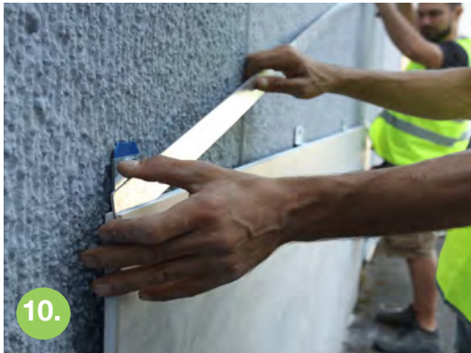
Inserire barra kerf sul pannello Insert the kerf plate on the panel
