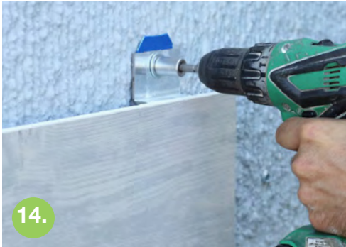
Applicare spessori sul retro delle staffe per regolare eventuali fuori piombo della muratura Apply shims on the back of the brackets to adjust any lead out of the masonry
