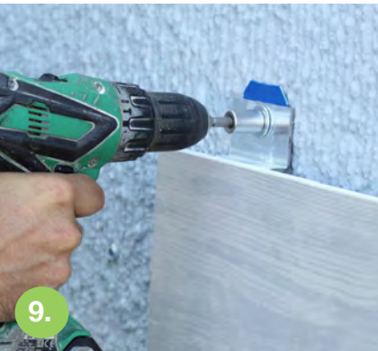
Serrare il tassello Tighten the dowel
