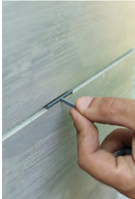
Innestare il pannello superiore sulla barra kerf inserendo i distanziatori per piastrelle della fuga desiderata (min 3 max 5 mm) Fix the top panel on the kerf plate by inserting the tile spacers of the desired grout line (min 3 max 5 mm)
