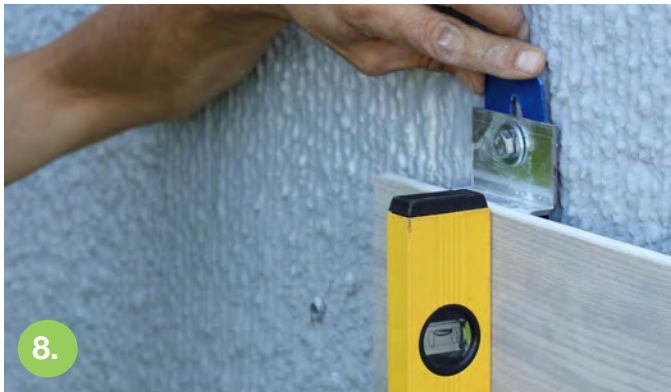
Regolare il pannello di partenza allineando sia il piano che la profondità (utilizzare spessori sul retro delle staffe per regolare eventuali fuori piombo della muratura) Adjust the starting panel aligning both the plane and the depth (use shims on the back of the brackets to adjust any lead out of the masonry)
