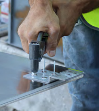
Posizionare i rivetti in dotazione sulla staffa e serrare la staffa Place the supplied rivets on the bracket and tighten the bracket
