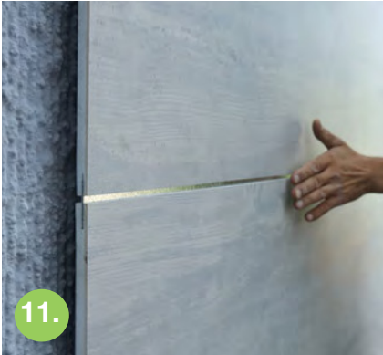
Innestare il pannello superiore sulla barra kerf inserendo i distanziatori per piastrelle della fuga desiderata (min 3 max 5 mm) Fix the top panel on the kerf plate by inserting the tile spacers of the desired grout line (min 3 max 5 mm)
