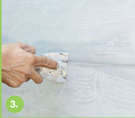
Stendere silicone con apposita spatola
