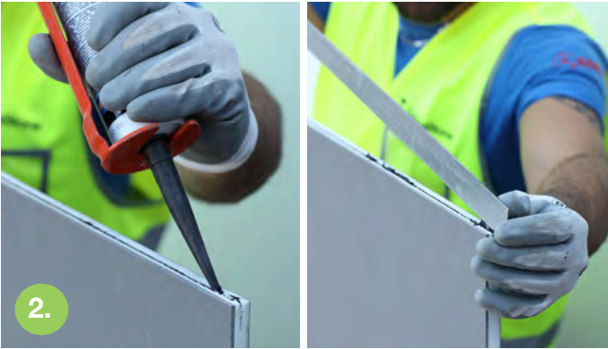
Dopo aver fissato pannello inserire barra kerf
