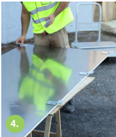
Fissare le staffe di base e le staffe superiori tramite rivetti in dotazione (fare attenzione al giusto posizionamento delle staffe di partenza, devono essere fissate in modo opposto a quelle superiori) Fix the base brackets and the upper brackets using the supplied rivets (pay attention to the correct positioning of the starting brackets, they must be fixed opposite to the upper ones)
