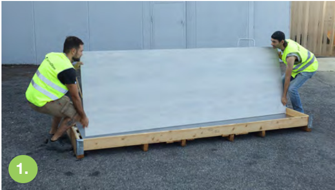
Prelevare il pannello dalla cassa in legno Remove the panel from the wooden box
