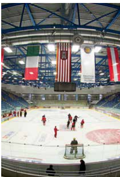
Pista di Pattinaggio a Bietigheim-Bissingen / Ice Rink in Bietigheim-Bissingen
