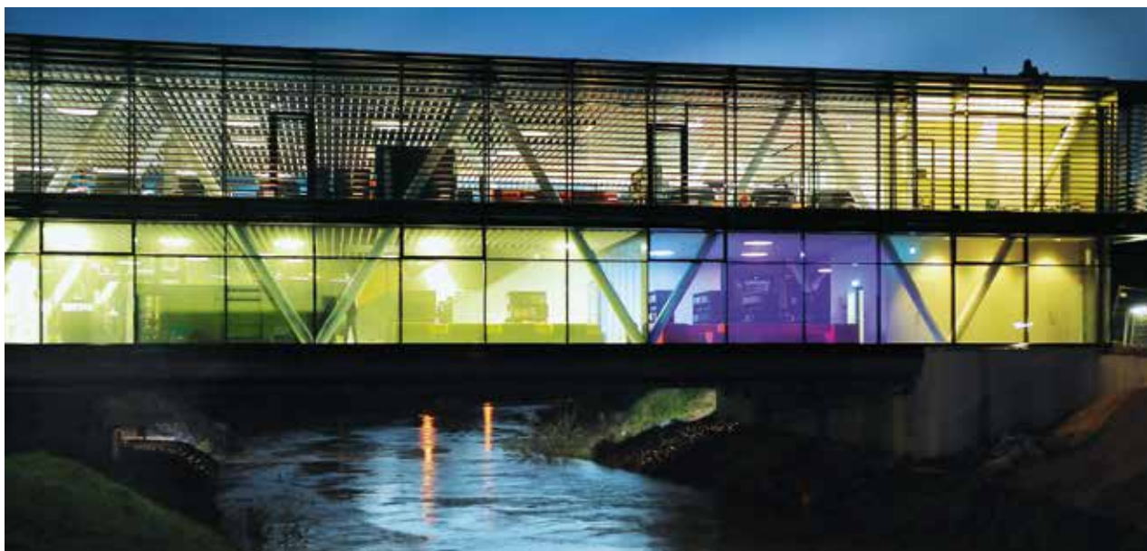
Protezione antincendio Acciaio: Biblioteca a Bad Vilbel / Fire protection Steel: Library in Bad Vilbel
