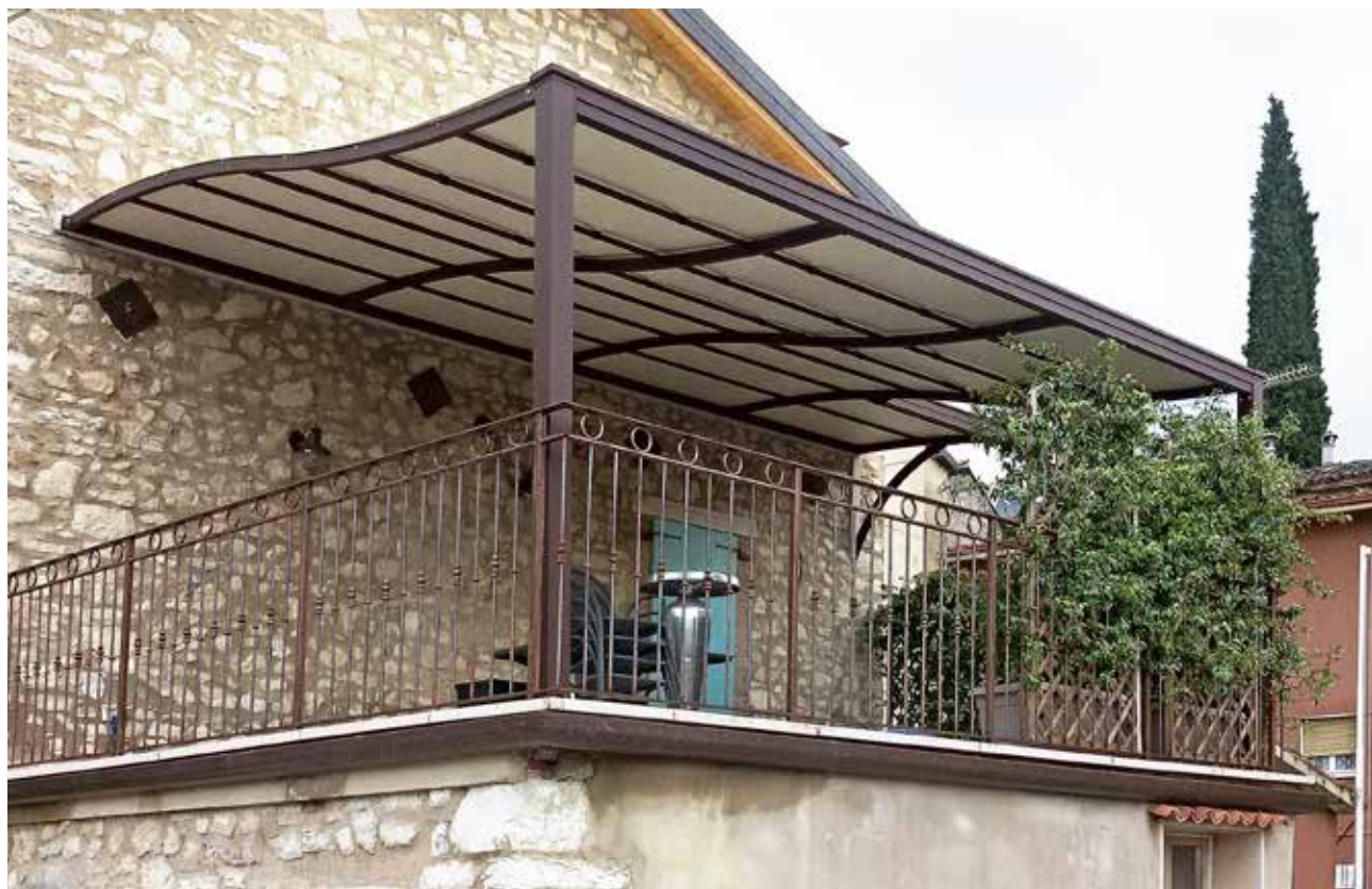
Canale raccolta acqua
