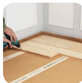
GUTEX Thermosafe-nf ® con listello in legno su tavolato massiccio
