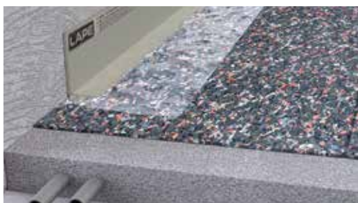
Posa striscia perimetrale
